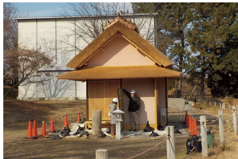
写真2-12 袖垣（南側）実寸模型設置状況 （南側より）
