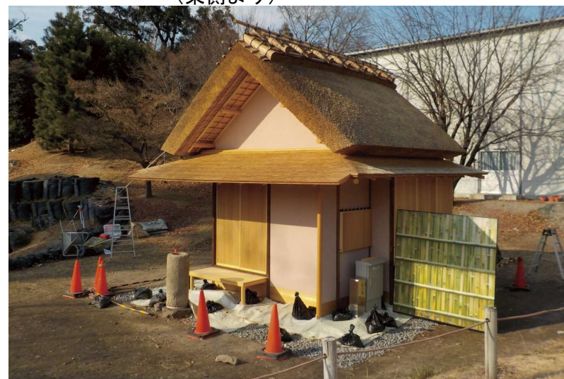
写真2-15 袖垣（東側）実寸模型設置状況（角度0度） （南東側より）
