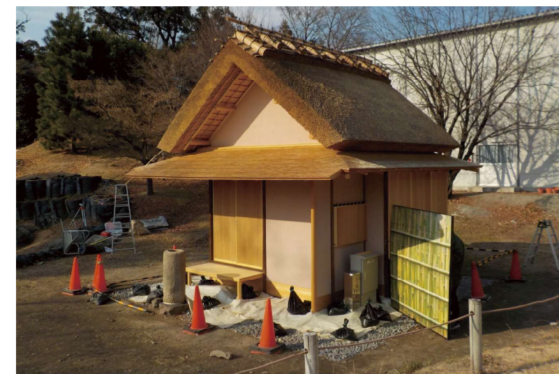
写真2-16 袖垣（東側）実寸模型設置状況（角度45度） （南東側より）
