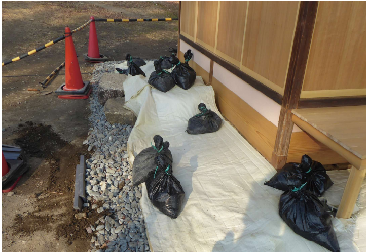
写真5-1 熨斗瓦設置状況
