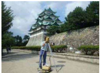
写真 2.1 基準点測量状況
