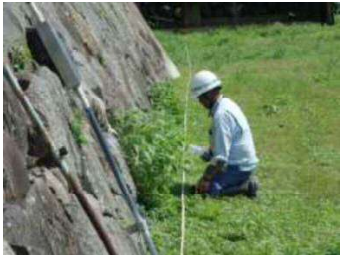
写真 2.2 標定点・リフレクター 設置・観測状況
