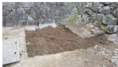
図 4.8 埋戻し状況
