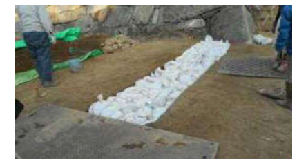
図 4.4 仮埋戻し状況
