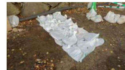
図 4.19 仮埋戻し状況
