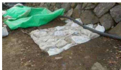
図 4.17 仮埋戻し状況
