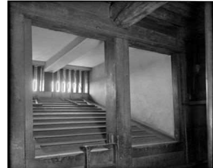
写-6.2.22 ガラス乾板「天守閣地階内東側窓」 ・明り取り窓(北東)の壁・天井
