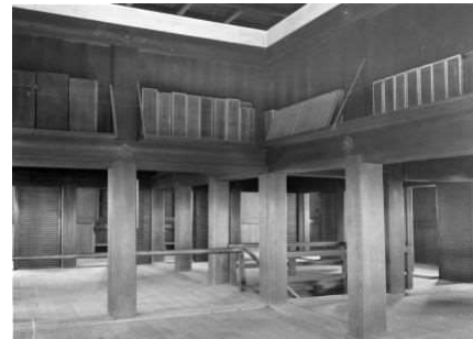
写-6.2.21 ガラス乾板写真「天守閣五階内長押上」 ・五階各部屋の蟻壁
