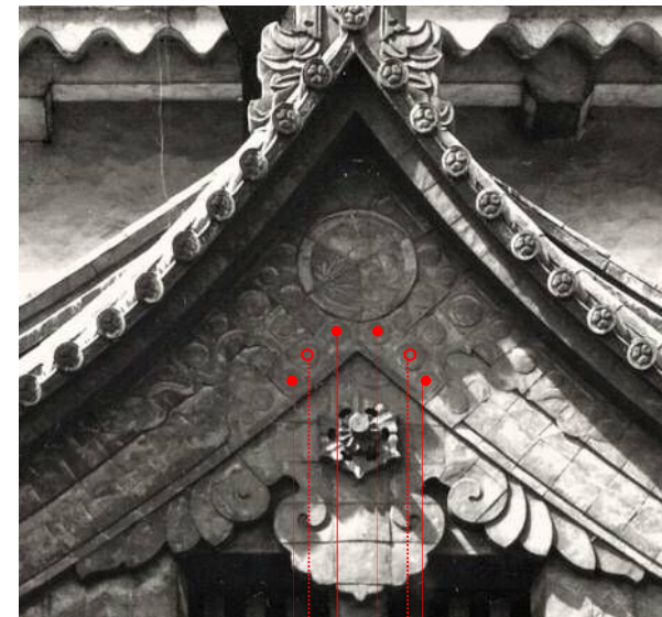
写-6.2.13千鳥破風破風板飾金具焼損遺物
