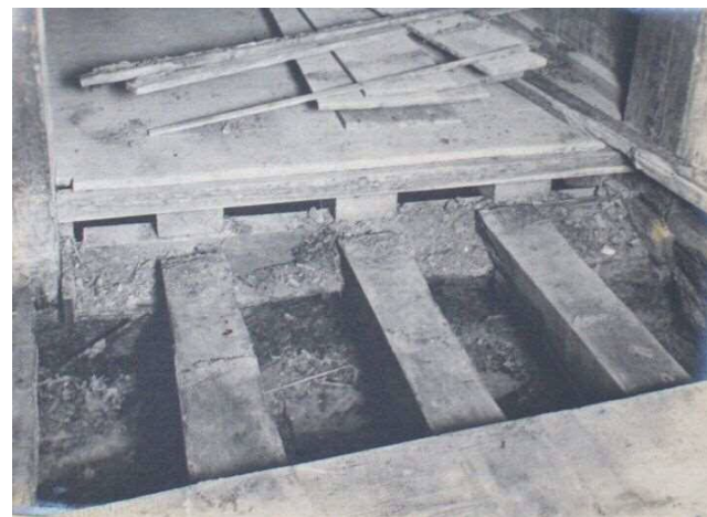
写-6.2.28「蟻害調査写真帳 名古屋離宮 二条離宮(写真帳)」(宮内公文書館所蔵) 「第二十七図 全上地層南面床組材ノ被害」(大正6年撮影)
