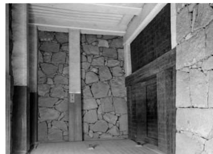
写-6.2.24 ガラス乾板「天守閣地階入口内側」 ・地階桁形の天井全面、柱、梁 ・奥御門冠木上の柱・梁(桁形側)
