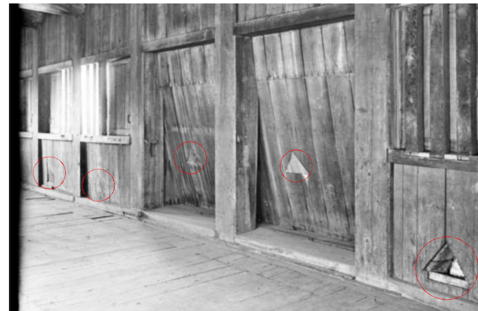
写-6.2.18 名古屋城総合事務所所蔵ガラス乾板写真 「天守閣一階内橋台上南側の石落及び鉄砲(焼失)」 右端部の狭間は蓋が外れており、外壁下地を確認できる
