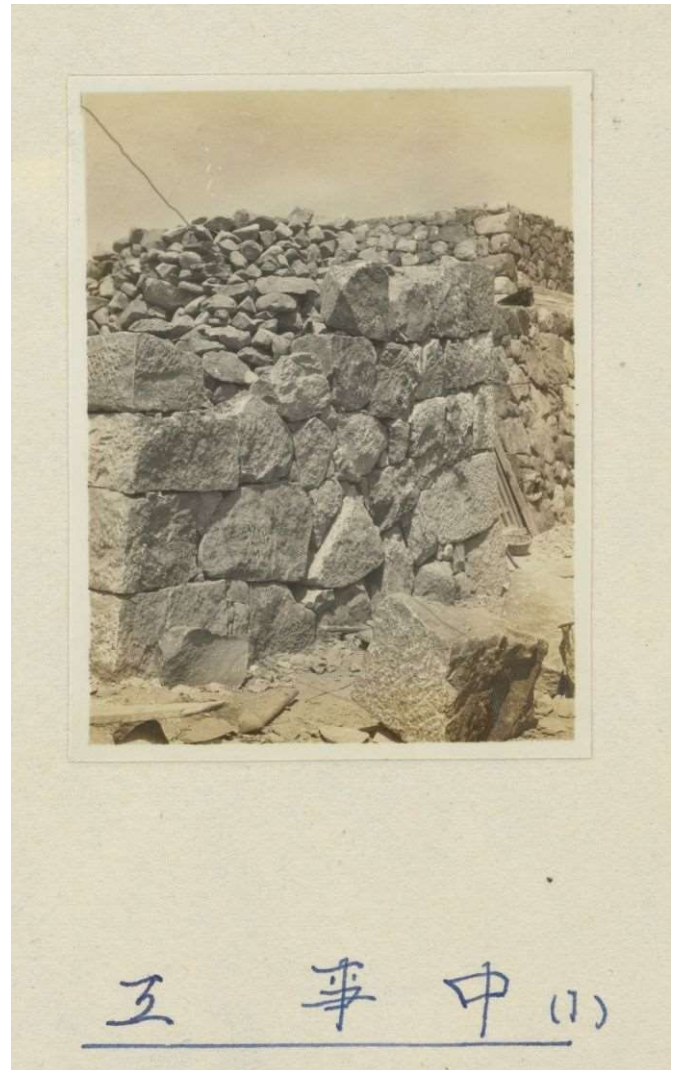
B 小天守SA02 積直し工事中
