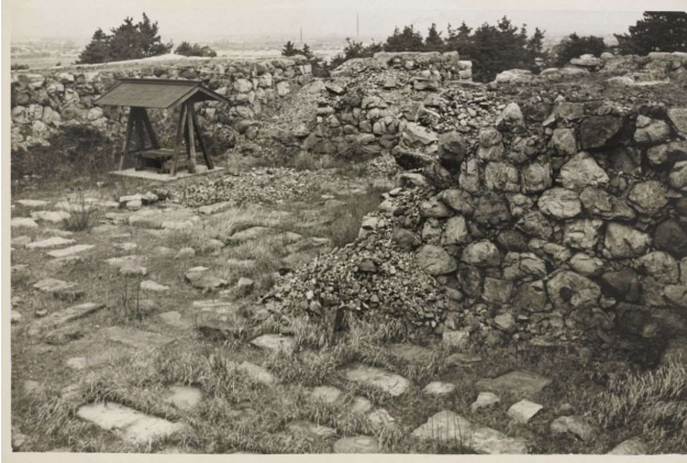
桁形、開口部周りの角に崩壊している部分がある。
