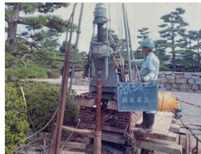
実施例 ボーリング調査状況
