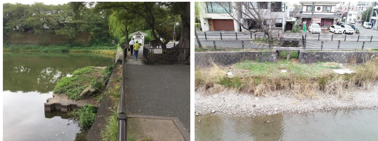
平成 10 (1998) 年度に実施された外掘護岸改修工事の際に設置された (幅 12.5m×奥行き 2.5m)。鋼矢板 (長さ：4 m) で囲い、土を埋め戻し、上部にコンクリート (厚さ：10 cm) を打設したもの
