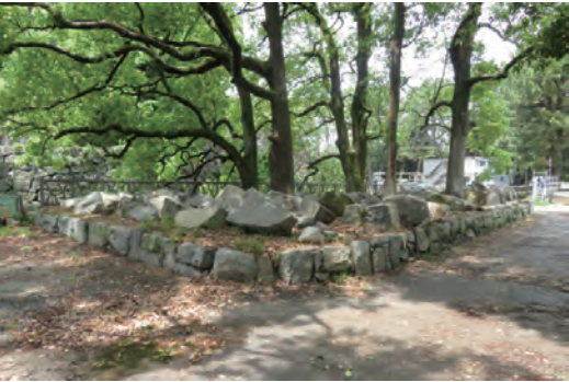
写真② 北側低石垣（南東から）
