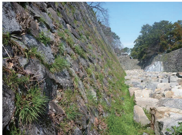
石垣裾部の状況
