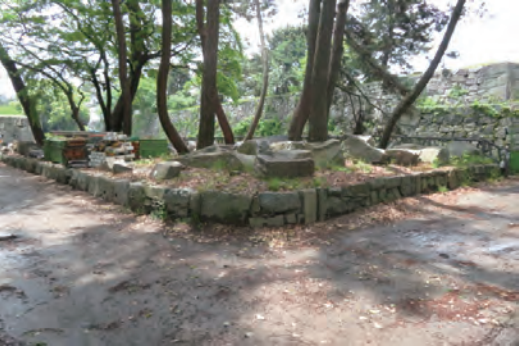
写真③ 南側低石垣（北東から）
