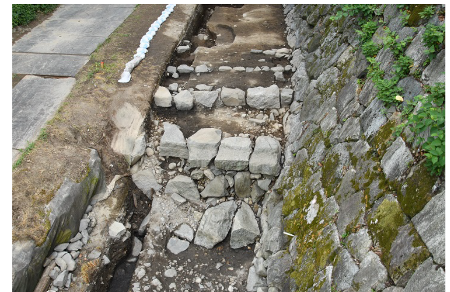
SS1 ～ SS4(北から)
