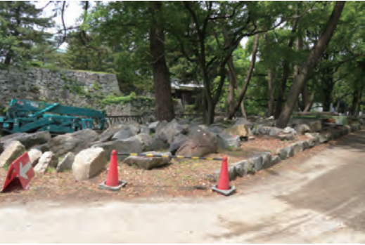
写真④ 南側低石垣（南東から）
