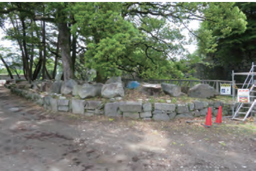
写真① 北側低石垣（北東から）
