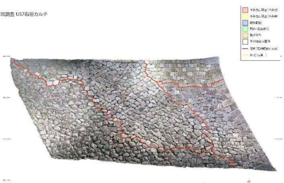
図4 小天守西側内堀石垣 U57 の事例
