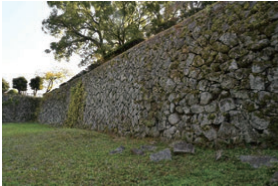
図 4-22 027H 石垣の状況
