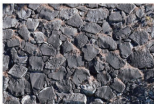
乱積（本丸005H石垣） 石材の横のラインが乱れる
