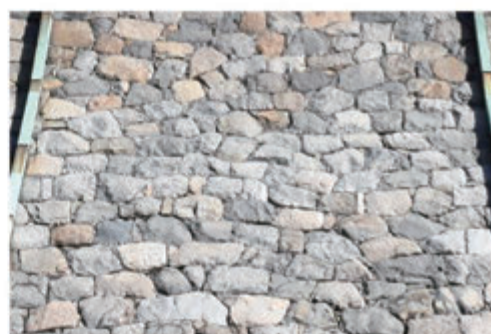
布積み崩し（本丸010H石垣） 石材の横のラインがある程度揃う
