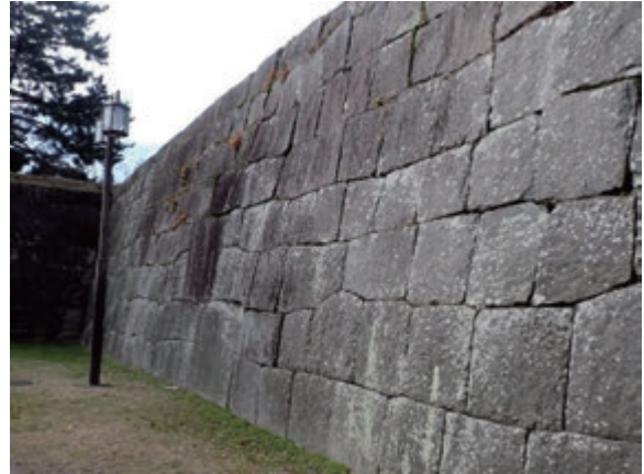
図 4-30 200N 石垣面の膨らみ
