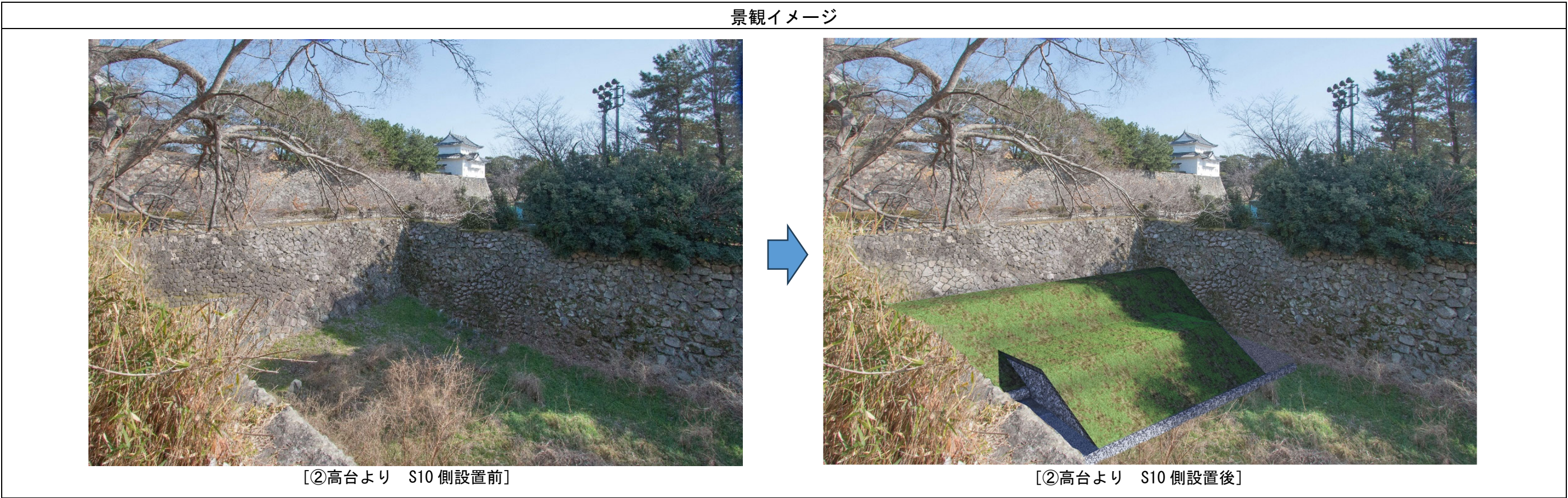
図 9 前押さえ対策(布団籠+覆土)の景観イメージ(S10)
