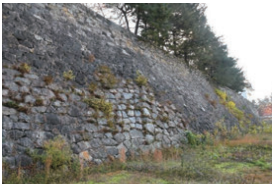
図 4-23 005H(U56)表面の膨らみ
