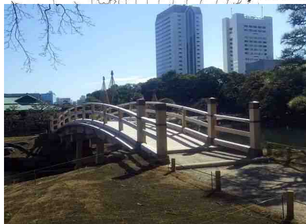
出典) 特別名勝・特別史跡 旧浜離宮庭園 中島橋(有効幅員約1.8m、橋長約16.0m)
