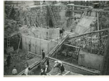
大天守の桁形の石垣をはずし、ケーソンを施工している
