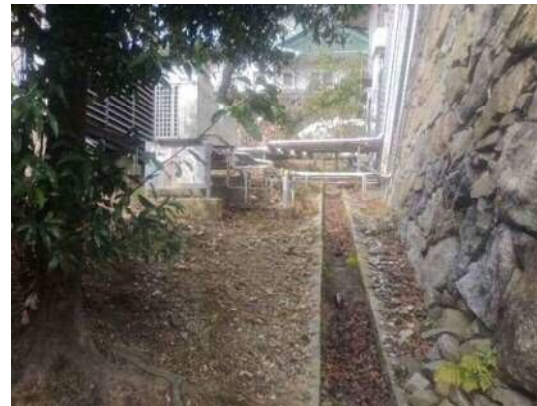
小守南西隅から見上げる
