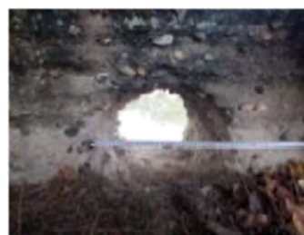
写真2 狭間部(南側より)
