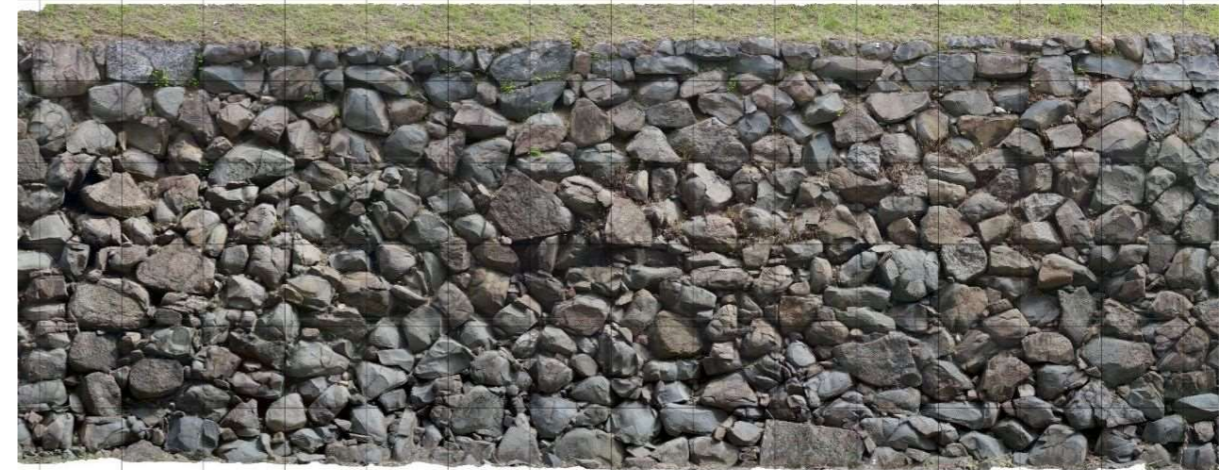
U65石垣面オルソ(部分)
