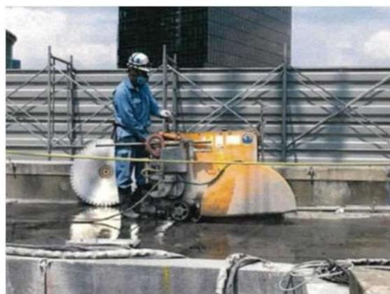
写-7.2.2 ウォールソーによる切断状況例
