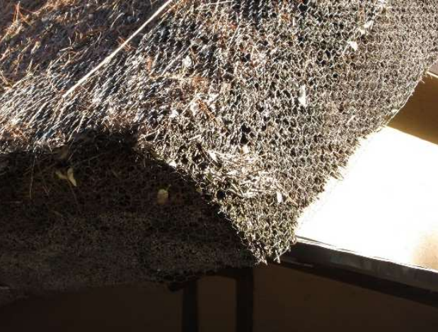
写真6 ネット工法の事例（拡大）
