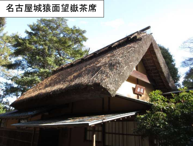
写真5 ネット工法の事例 （平成 30 年度（2018）設置）
