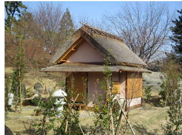
写真 1 余芳全景（南東面）
