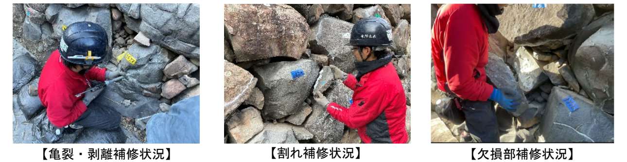
図 4 石垣 U65 の補修手法・補修状況 2
