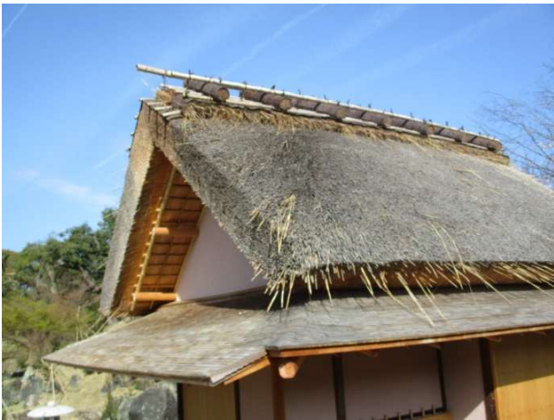
写真 2 余芳屋根面拡大（軒先・棟飾り）
