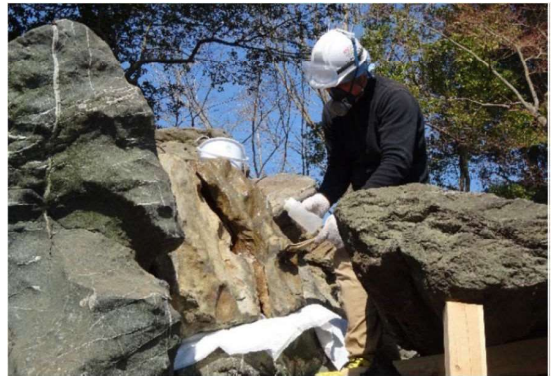
写真 2-5-10 石材強化/薬剤塗布の施工状況（平成 29 年度）
