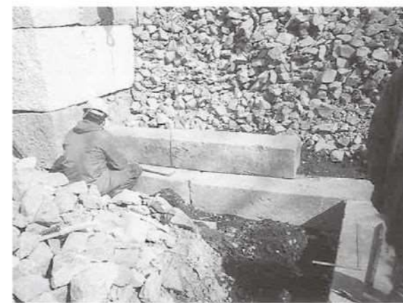
④二之丸東二の門 (南側) 平成11年積み直し時
