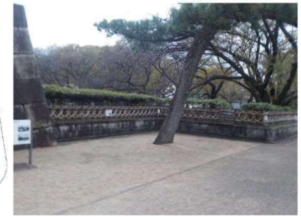
⑥榎多門 現況写真
