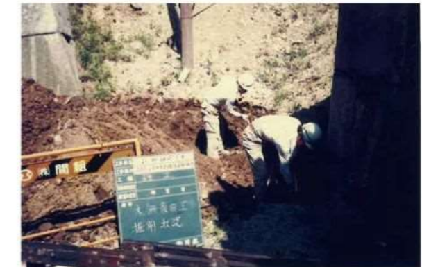
図6 昭和60(1985)年度 表二の門木柵復旧状況
