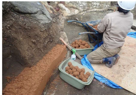
写真 2-5-9 石組補修/粘質土突き固めの施工状況（平成 29 年度）
