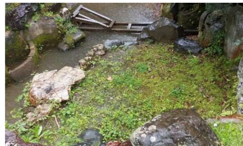
①北池護岸背面(北西から)
