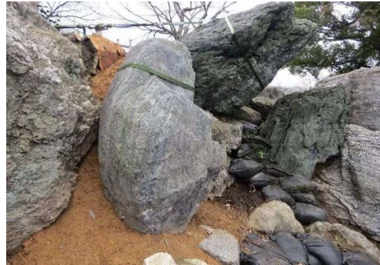
写真 2-5-8 石組修復（据え直し）完成状況（令和元年度）
