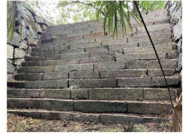
(東北隅櫓石段 現況写真)
