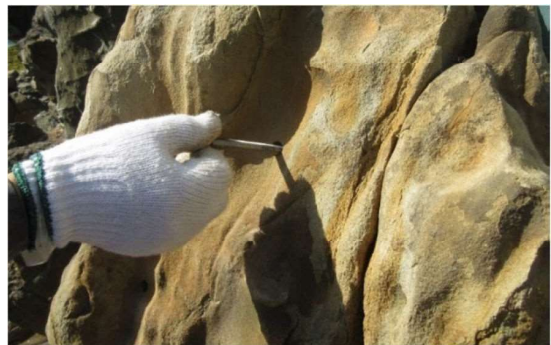
写真 2-5-11 石材補修/ステンレスボルトの挿入状況（平成 29 年度）
