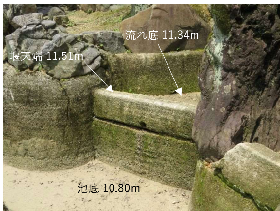
写真4-3-11 水系設備とみられる護岸構造物
