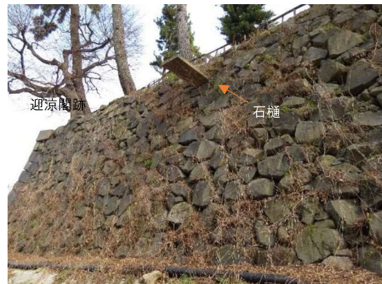
写真 3-2-6 使われていない石垣北西部の石樋
