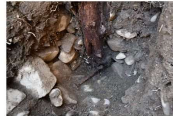
図5 令和元(2019)年度 脇塀控柱発掘調査状況
