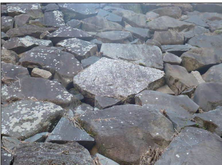
No.: 9 石垣名称 本丸地区 037H 測点: 平成4～5年度解体 修理新補材
