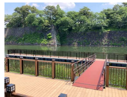
写真③ 浮棧橋
