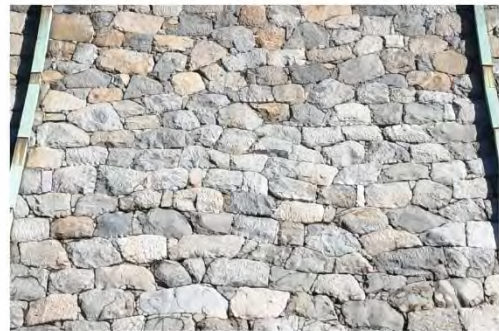
布積み崩し (本丸010H石垣) 石材の横のラインがある程度揃う
