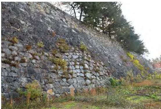
図 4-23 005H(U56)表面の膨らみ
