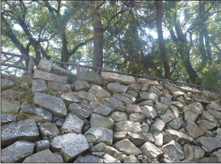
No.: 7 石垣名称 本丸地区 037H 測点: 天端石の積替え
