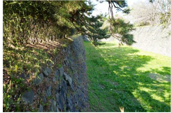
図 4-38 154N 石垣面の凹凸
