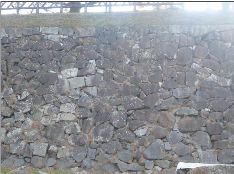
No.: 8 石垣名称 本丸地区 037H 測点: 平成4～5年度解体 修理箇所
