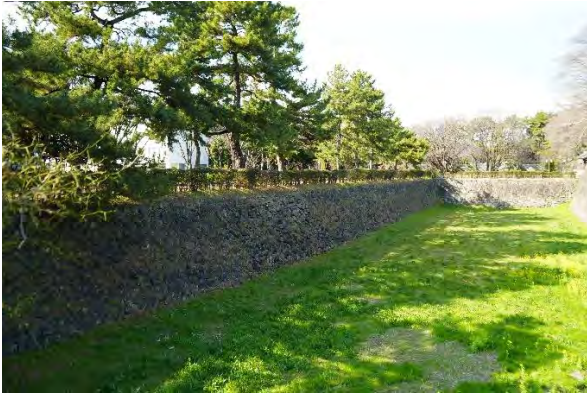
図 4-37 二之丸空堀外側の石垣
