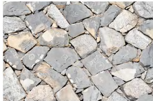
落とし積み(谷積み) (本丸004H石垣) 石材のラインが斜めに揃う
