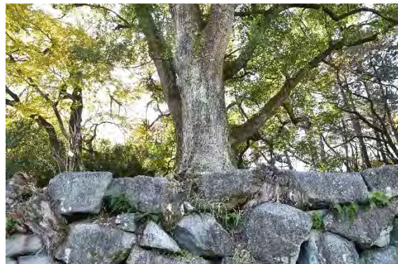
図 4-32 206N 樹木根による変形
