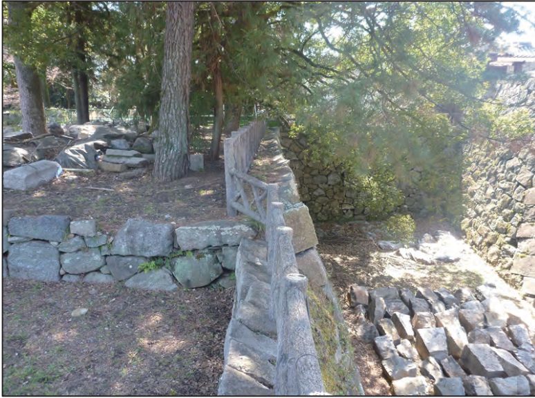
No.: 4 石垣名称 本丸地区 037H 測点: 天端部の状況
