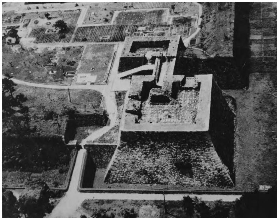
図 2-5 空襲後の天守台石垣周辺(名古屋城総合事務所蔵)
