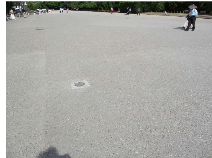
写真1 脱色アスファルトの施工事例 (名古屋城内)
