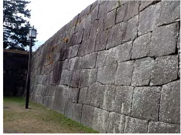
図 4-34 200N 石垣面の膨らみ
