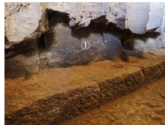
図 16 床下石垣拡大（東から）
