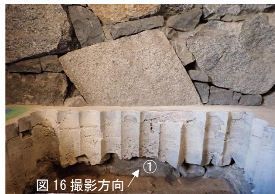
図 15 コンクリート床下の石垣（東から）
