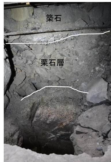
図 7 現石垣直下の栗石層と刻印を有する石材(西から)
