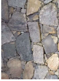
図09 H136天端状況.jpg
