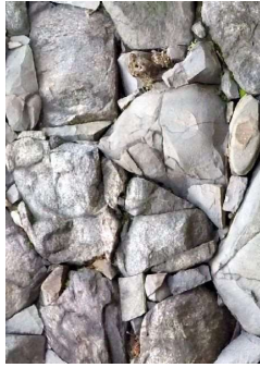
図05 H136_築石積熱状況.jpg
