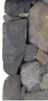
図11 H136開葺状況-2.jpg
