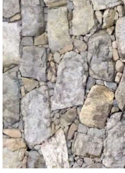
図08 H136開葺状況.jpg
