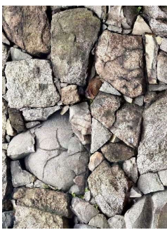
図04 H136_築石積熱状況.jpg
