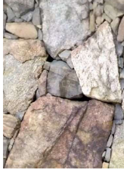
図10 H136開葺状況-1.jpg
