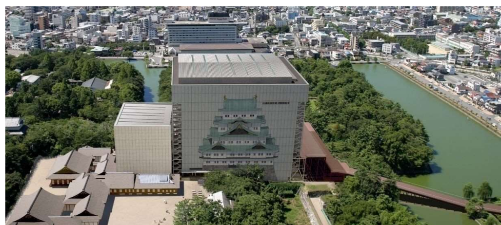
図-7.1.14 素屋根置完了イメージパース
