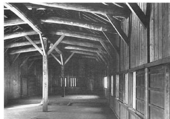
写-6.2.1 ガラス乾板写真「表一之門(焼失)上層内部北東面」
