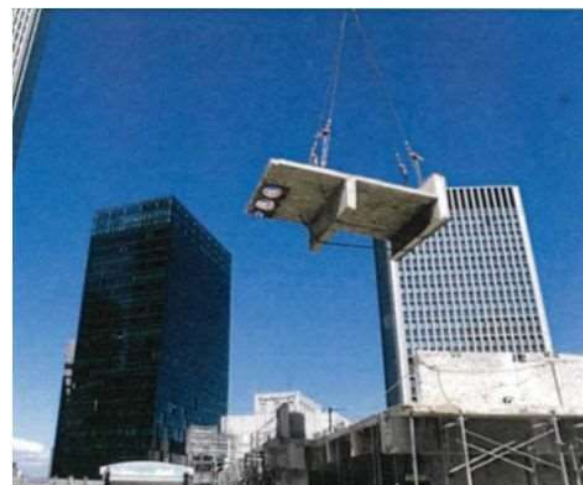
写-7.2.1 ワイヤーソーによるブロック解体場重作業例
