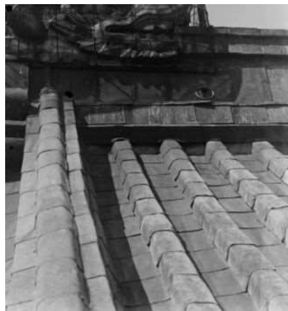
写-6.2.2 ガラス乾板写真「金鯱(南法)(焼失)②」(部分) ・5重の銅瓦葺
