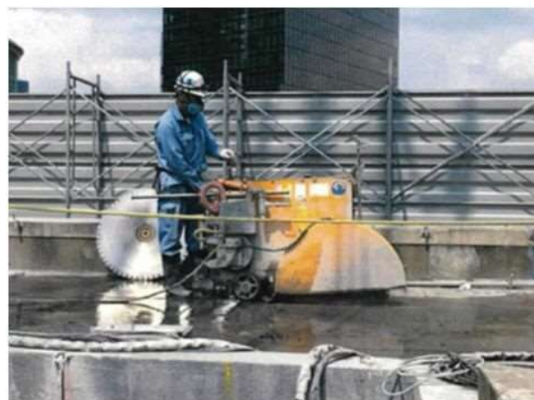
写-7.2.2 ウォールソーによる切断状況例
