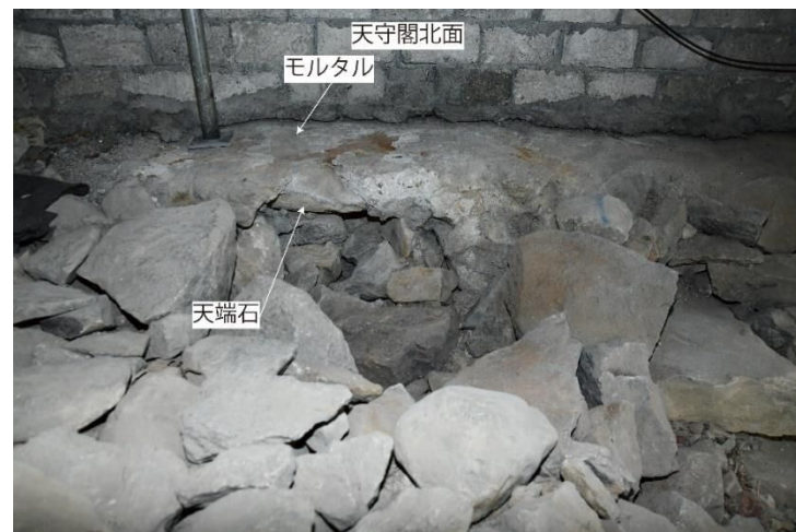
図 12 背面②調査区土築石(南から)
