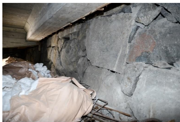
図 16 調査区東側の石垣(東から)
