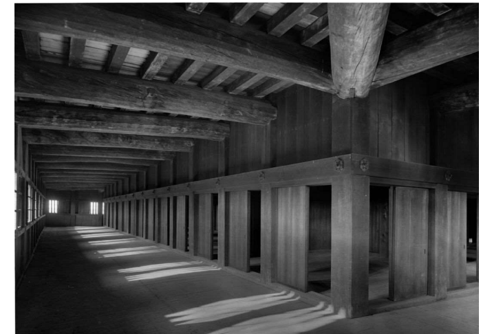
天守閣一階内西入側（焼失）
