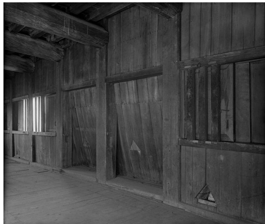
天守閣一階内橋台上南側の石落及び鉄砲狭間（焼失）
