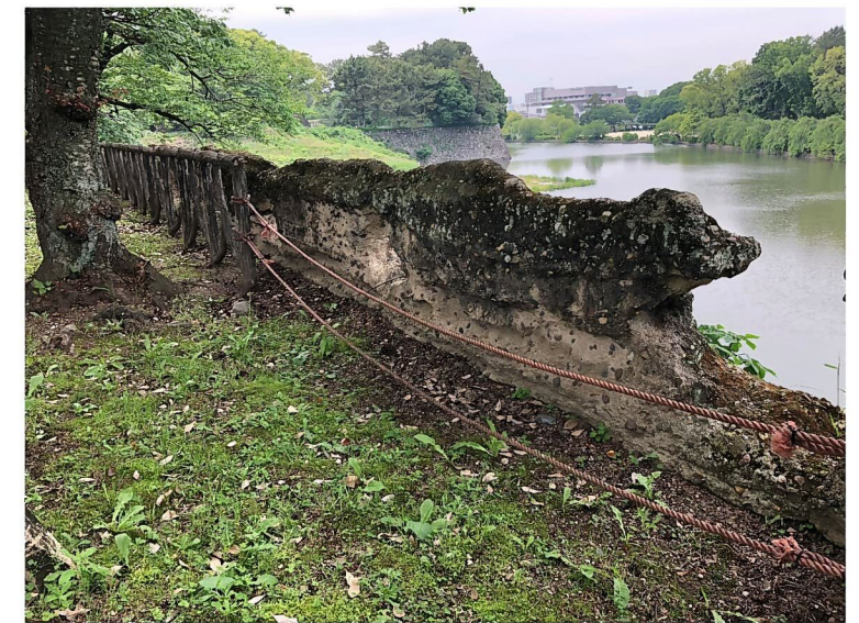
写真 1-3 南蛮練堀（近景 南東側から撮影）
