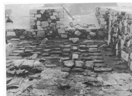
東面明取り方向を望む
