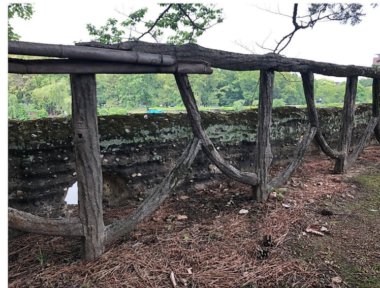
写真 1-2 南蛮練堀（近景 南西側から撮影）
