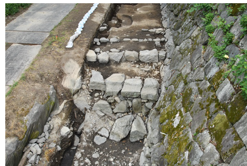
SS1 ～ SS4(北から)
