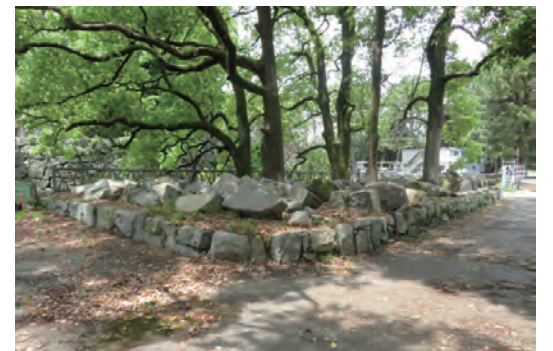
写真② 北側低石垣 (南東から)
