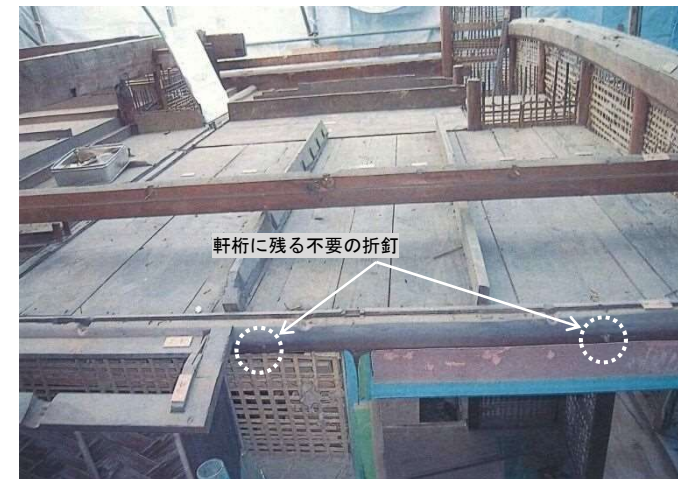
写真③ 小屋組の解体状況（H23年度） 板の間部分の丸太の軒桁に不要の折釘が残存。下屋軒桁の当初材と判断できる。
