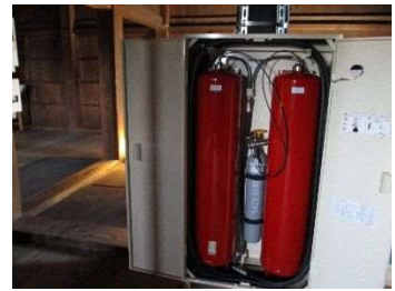
屋内消火設備 (1階・2階) (パッケージ型消火設備)
