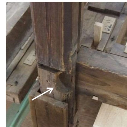
(へ五柱南面) 濡縁框の痕跡
