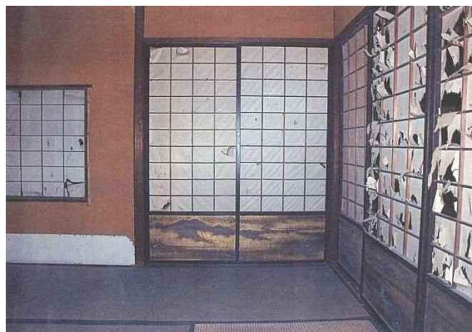
写真③ 余芳亭 内部（平成23年度解体前写真）
