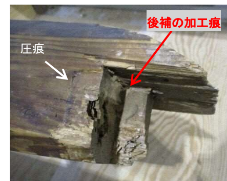
四通り小屋梁の仕口(南面)
