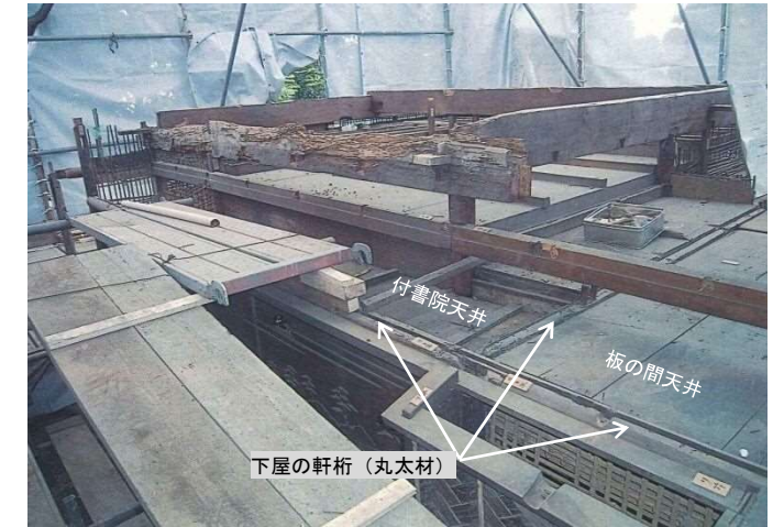
写真② 小屋組の解体状況（H23年度） 下屋軒桁の当初材が残存。丸太の軒桁には、不要の折釘が一定の法則で打たれていた。掛雨戸の掛釘と推定。
