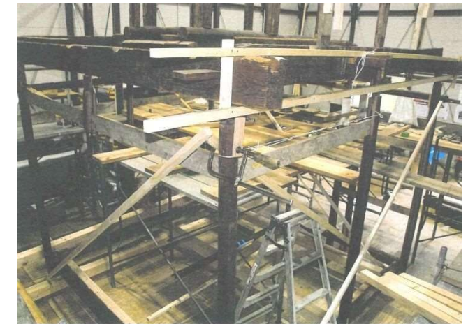
仮組状況②
