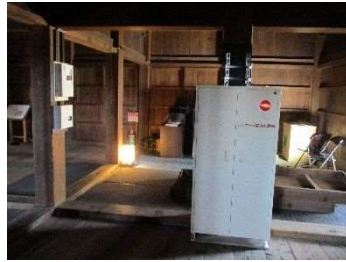
屋内消火設備 (1階・2階) (パッケージ型消火設備)
