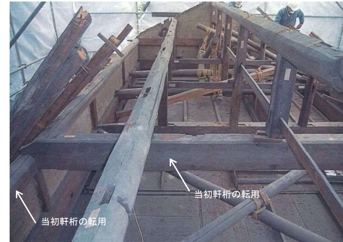
写真① 小屋組の解体状況（H23年度） 当初軒桁が水屋側に転用されていたことが判明。
