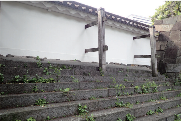
図5 江戸城田安門（控柱の据わる段が異なる）
