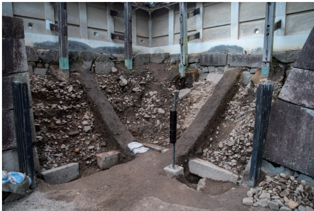
図2 西土塁 完掘状況（北東から）
