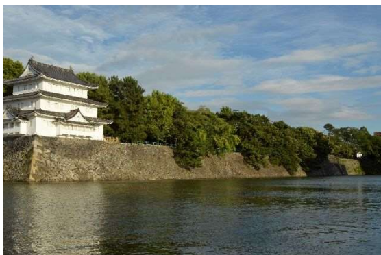
外堀（水堀）西面
