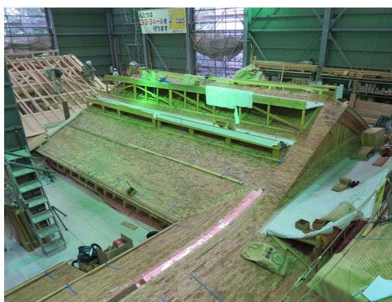
④[黒木書院] 屋根状況（南東より臨む）
