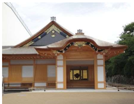
写真 本丸御殿（玄関・車寄外観） （現在）
