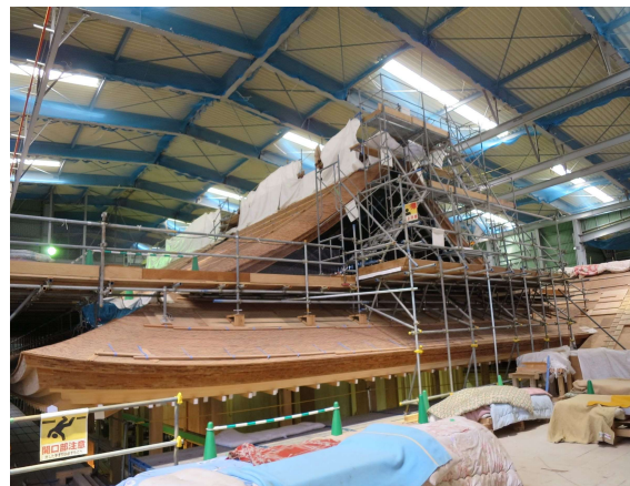
②[上洛殿] 屋根状況（東より臨む）
