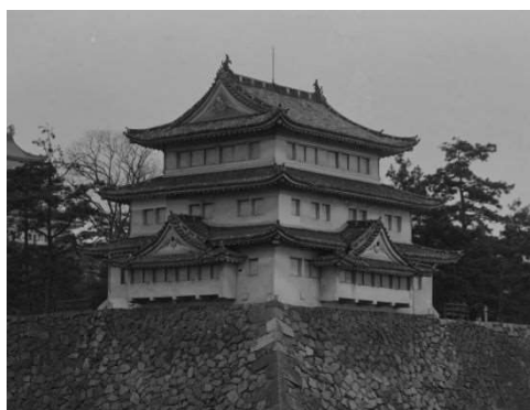
写真 西北隅櫓（昭和初期）
