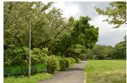
樹木で灯具が覆われた照明灯 (二之丸広場)
