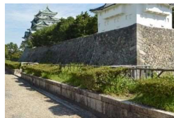
補植されていない灌木 （内堀外周）
