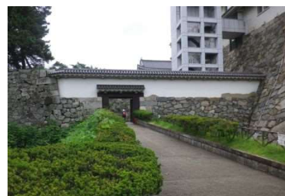
急勾配な園路（不明門付近）
