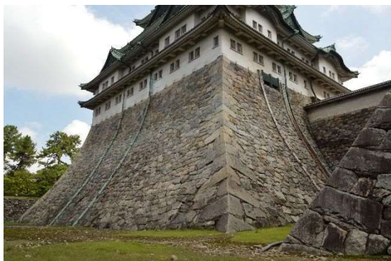
天守台石垣西南面
