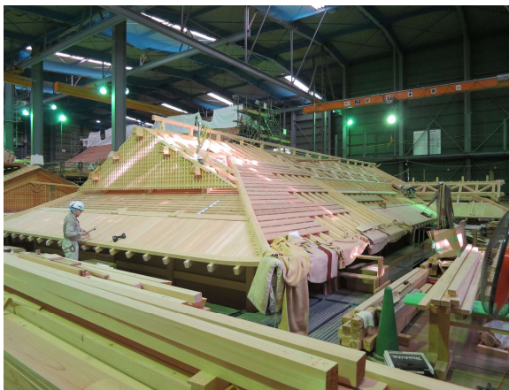
⑤[湯殿書院] 屋根状況（北西より臨む）
