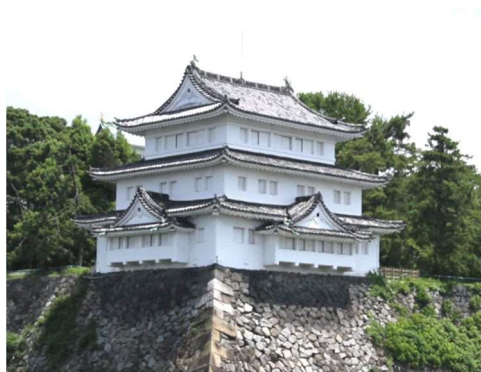
写真 西北隅櫓（現在）
