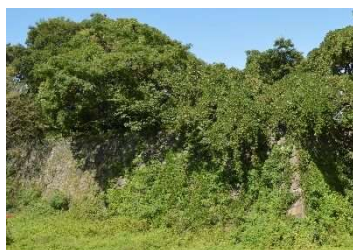
石垣を被覆する草本類 （南側石垣）
