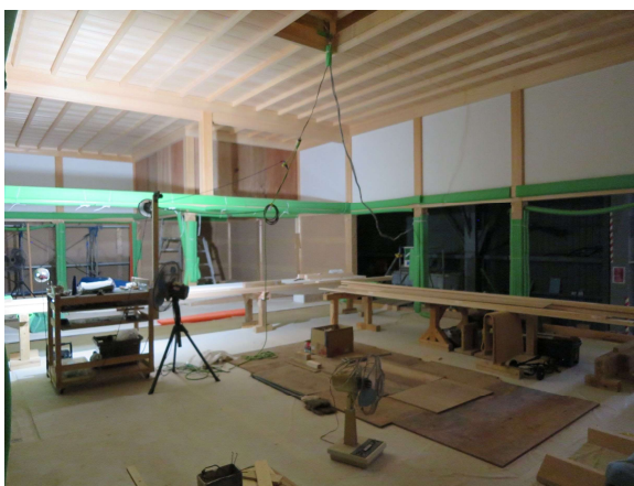
③[上御膳所] 内部状況
