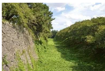
堀に繁茂した草本類 （西之丸南）
