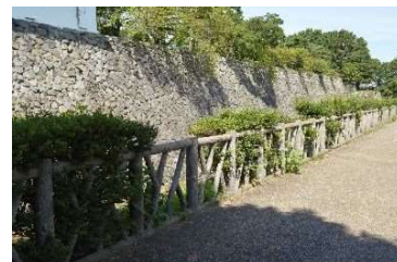
補植されていない灌木 （東南隅櫓東）
