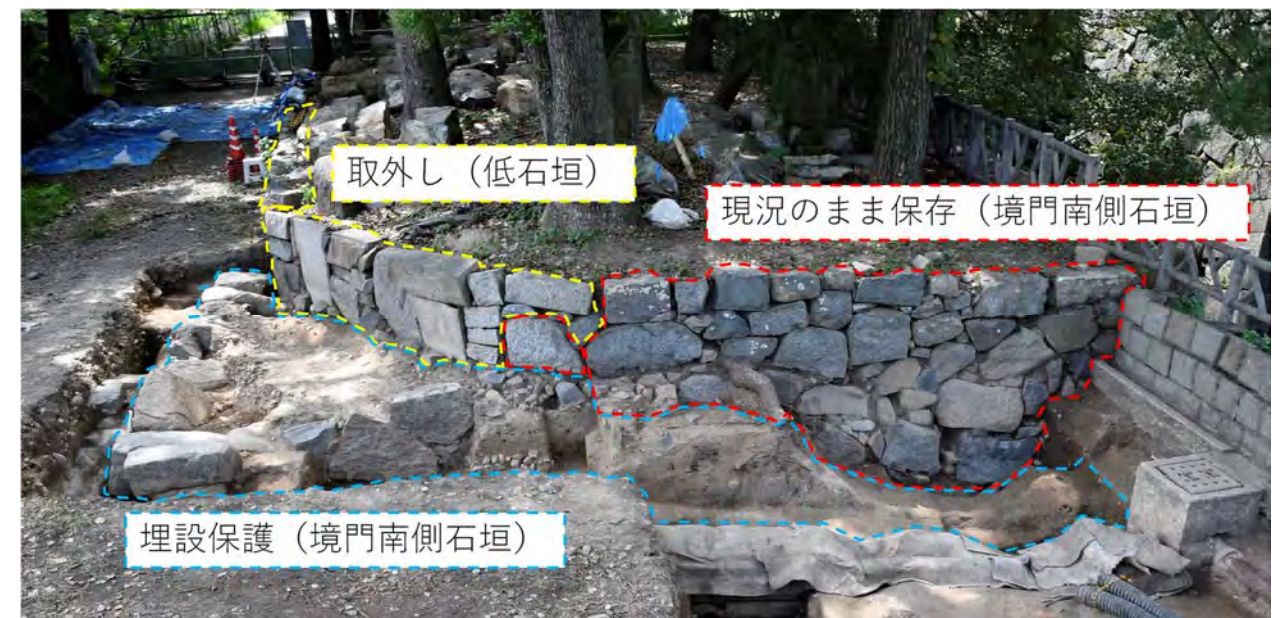
写真 1 令和 4 年度調査写真 境門南側石垣 (北より)
