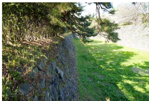
図 4-34 154N 石垣面の凹凸
