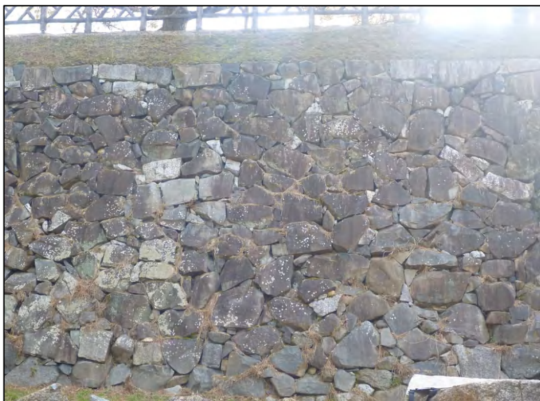
No.: 8 石垣名称 本丸地区 037H 測点: 平成4～5年度解体 修理箇所
