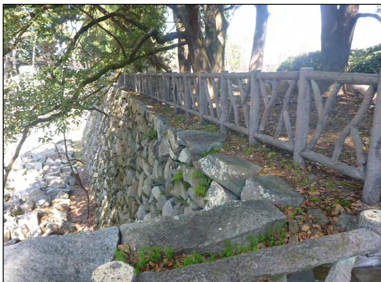
No.: 5 石垣名称 本丸地区 037H 測点: 天端部の状況
