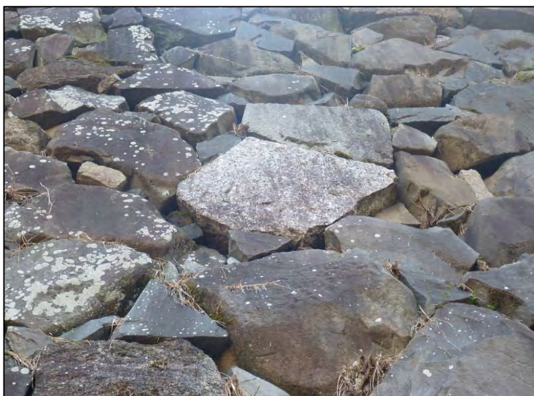
No.: 9 石垣名称 本丸地区 037H 測点: 平成4～5年度解体 修理新補材
