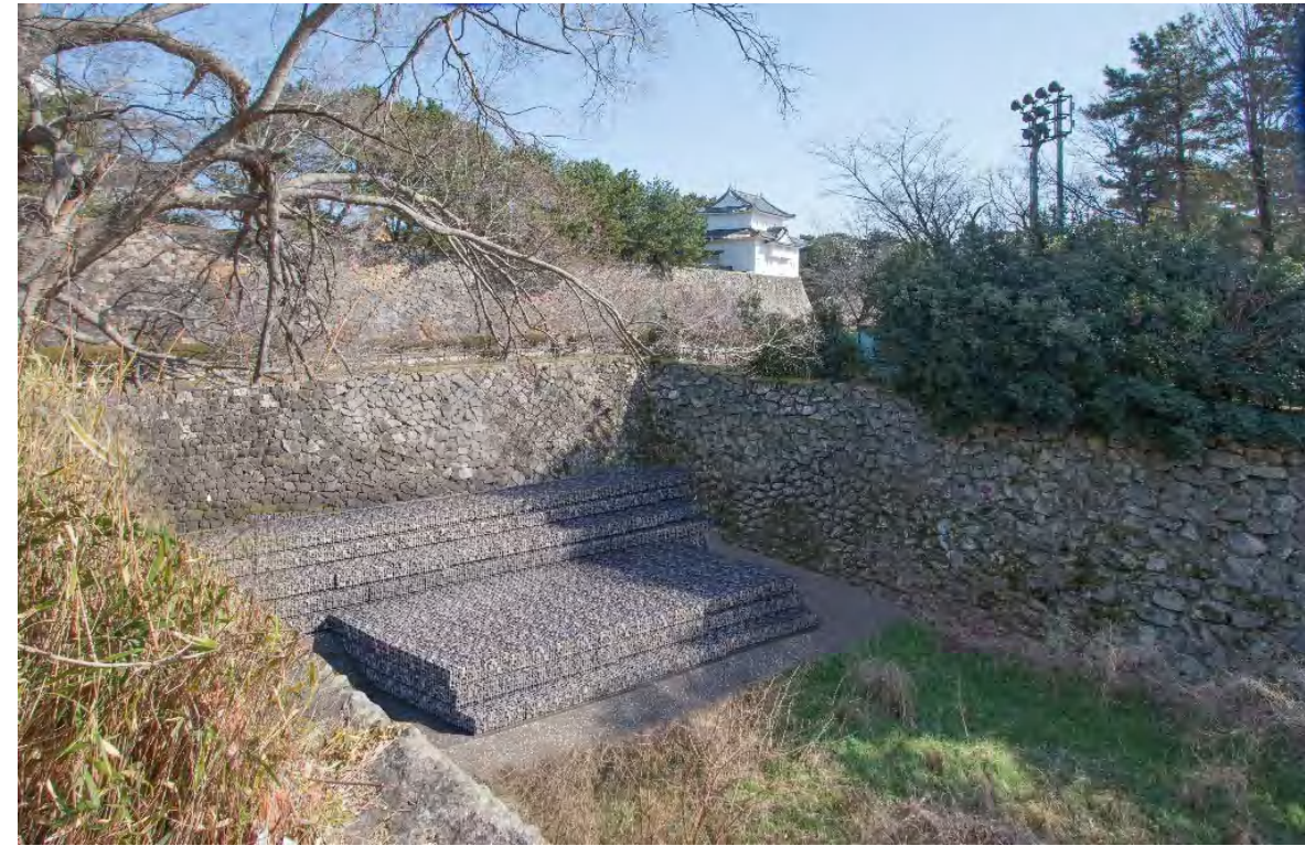
【②高台より S10 布団籠設置後】
