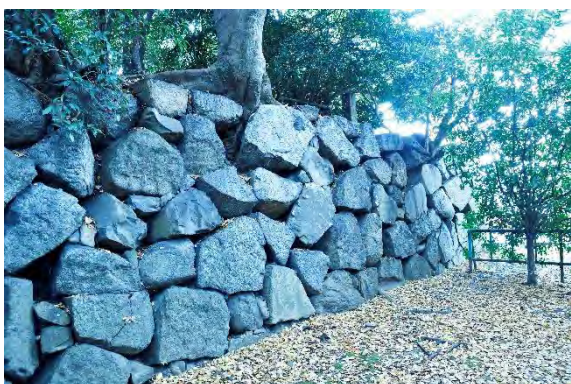
図 4-51 248〇 樹木根による変形
