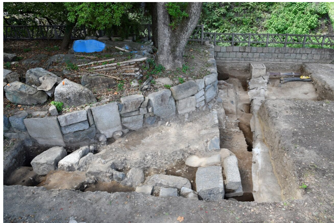
写真1 調査区全景（東から）
