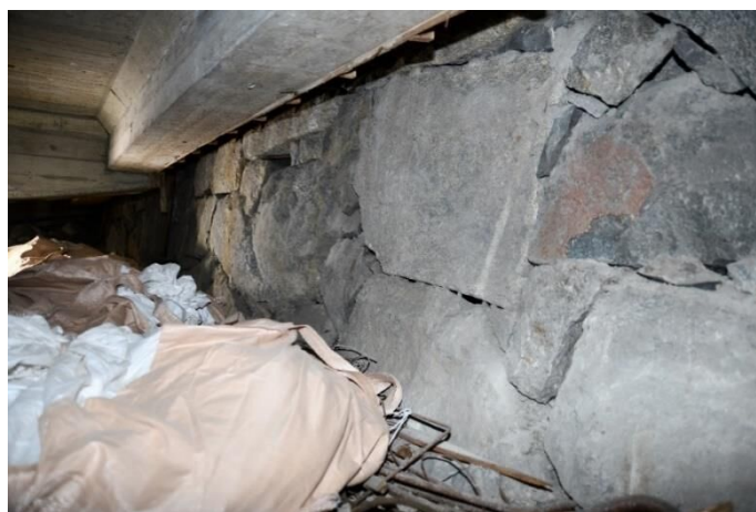
図 16 調査区東側の石垣(東から)
