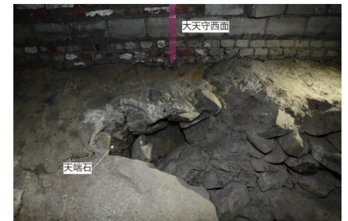
図 14 背面③調査区築石(東から)
