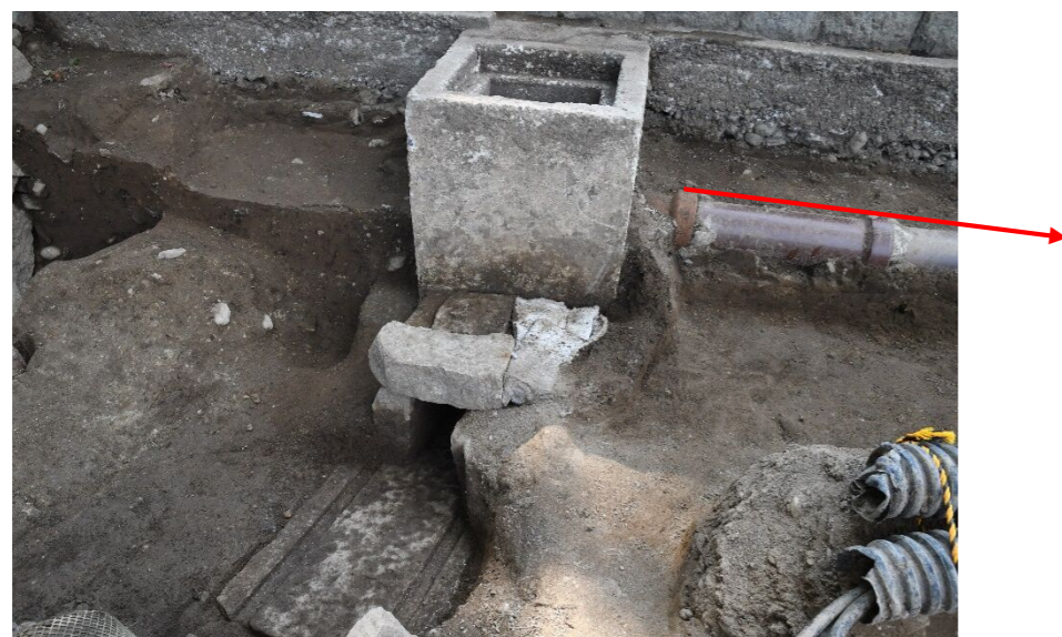
写真8 雨水枡との接続部（東から）
