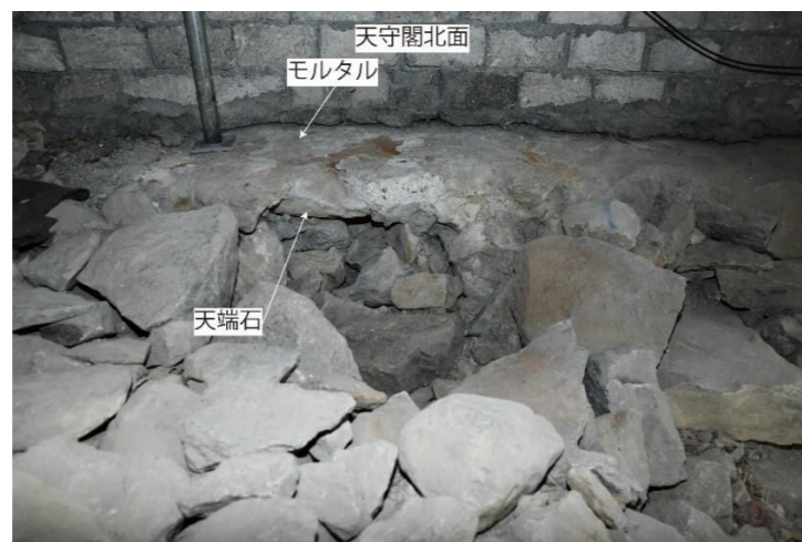
図 12 背面②調査区土築石(南から)
