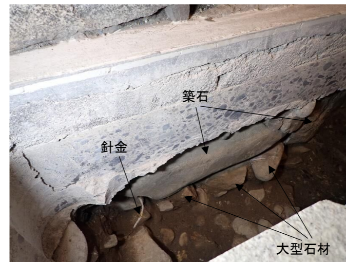
図 18 ⑤調査区西壁の築石と大型石材 (西から)
