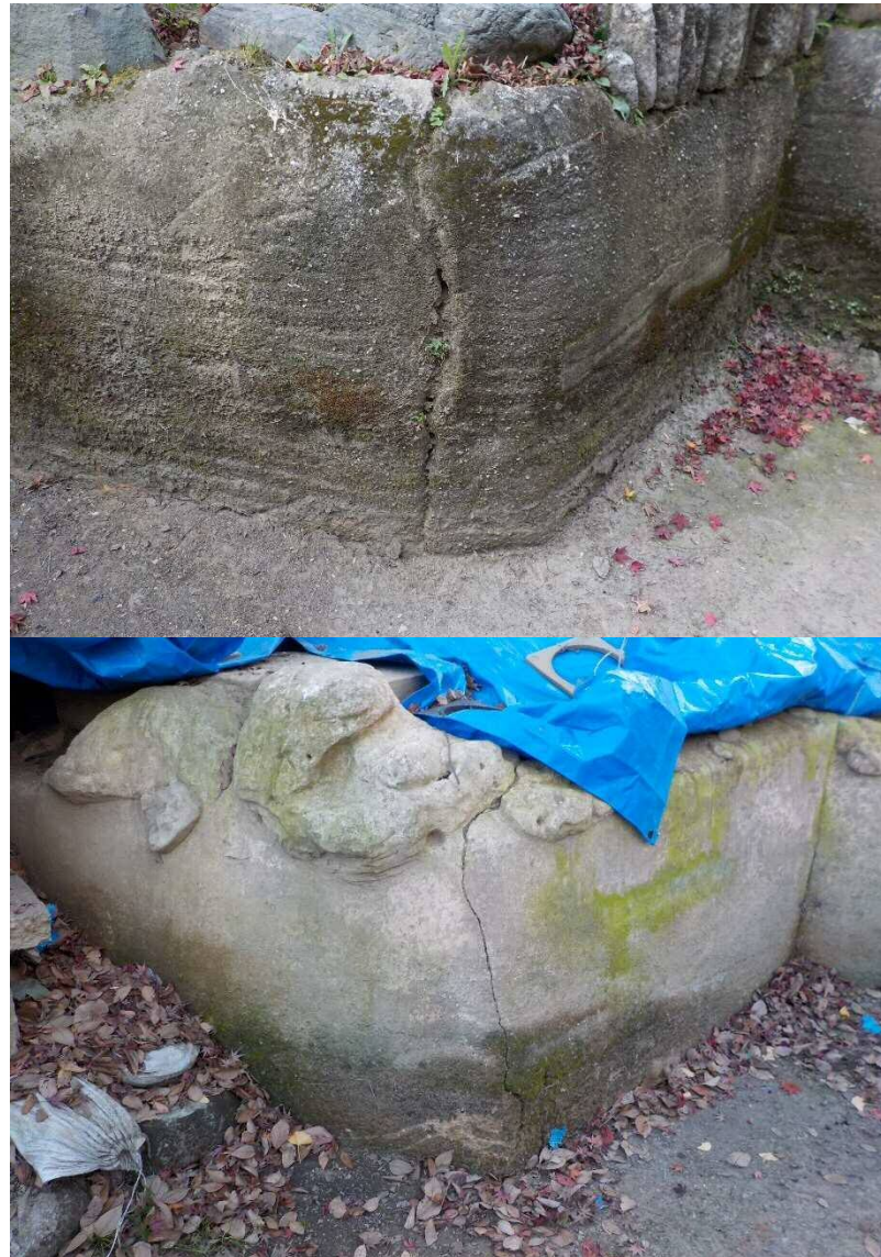
修理箇所の例（写真）
