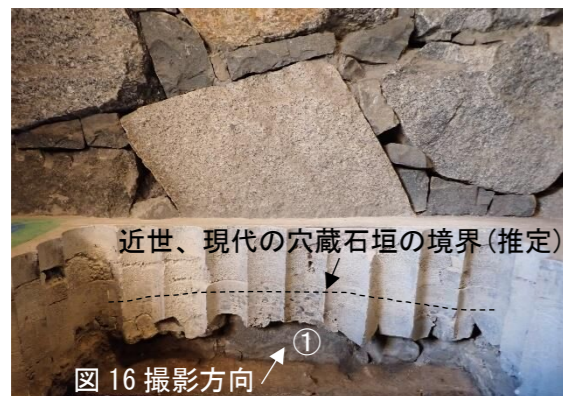
図 15 コンクリート床下の石垣 (東から)
