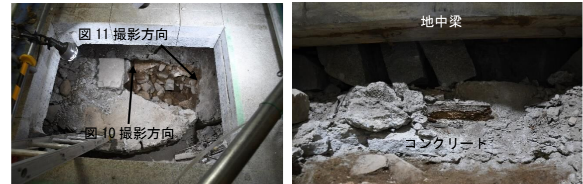
図 9 ③調査区全景(西から)
