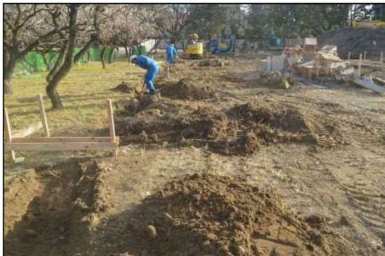
写真2 現場状況／北から
