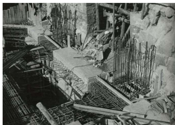
写真-4 小天守の基礎配筋（口御門付近）
