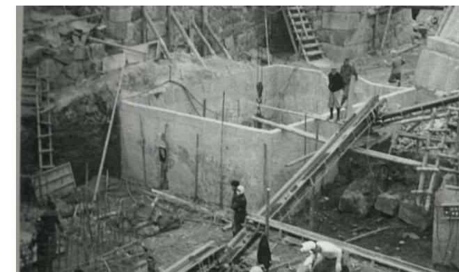
写真-1 ウォータージェット用配管の施工中（南東ケーソンの南面と推定）
