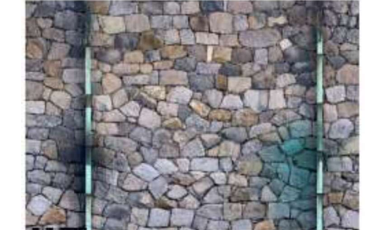
図07 U061_築石部中段_布積崩し.jpg
