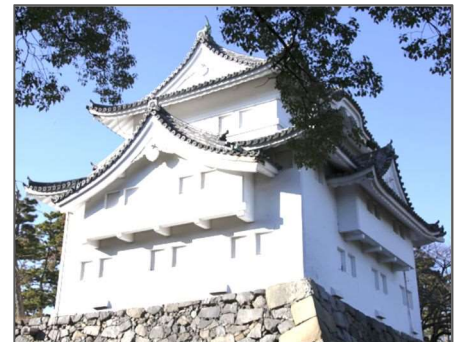
東南隅櫓（重要文化財）
