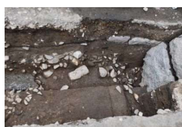
写真12 Z区天守台石垣前面
