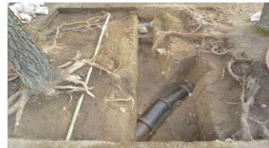
写真3 A区 完掘状況
