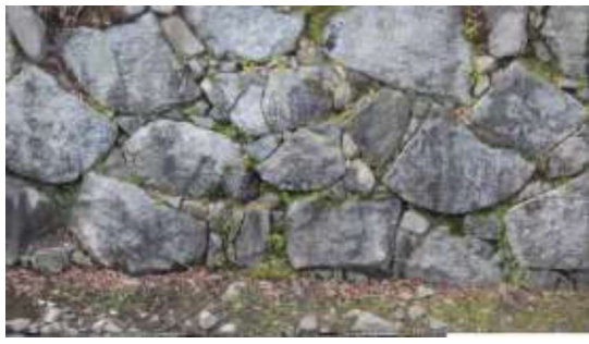
図03 U061_間詰石の状況.jpg
