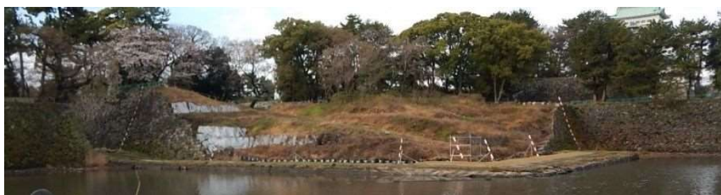
図2 解体完了写真
