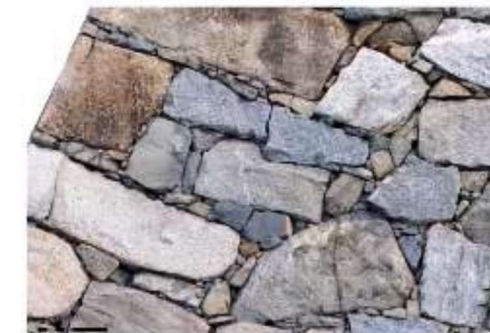
図10 U061_隅角部中段_クリコミ.jpg
