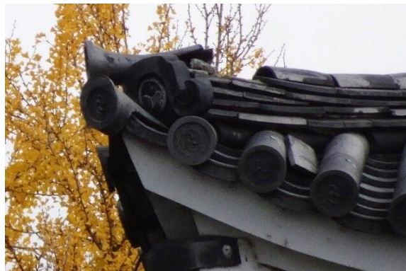
写真 2-6【西北隅櫓（A03）】瓦の脱落
