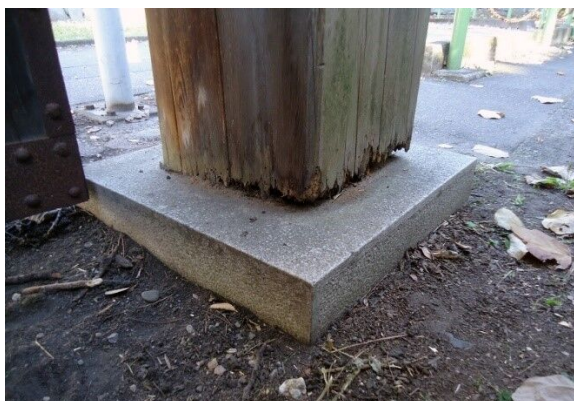
写真 2-11 【二之丸大手二之門（A04）】柱脚腐朽
