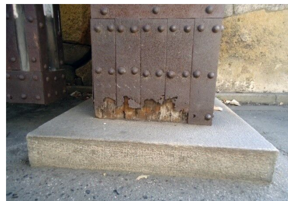
写真 2-12 【二之丸大手二之門（A04）】金属腐食
