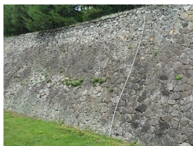
写真 3-10 西南隅櫓西側石垣の膨らみ
