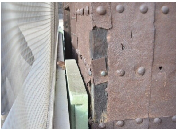
写真 2-8【表二の門（A04）】金属腐食
