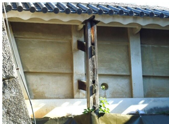
写真 2-10 【表二の門附属土塼（A04'）】控え柱腐朽
