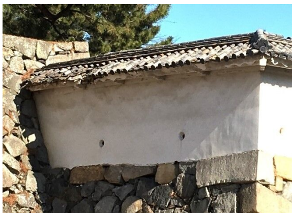
写真 2-9 【表二の門附属土塼（A04'）】屋根瓦欠失
