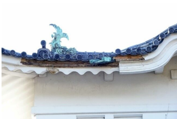
写真 2-3【東南隅櫓（A02）】漆喰、塗土剥離
