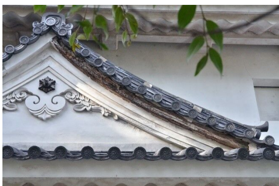
写真 2-5【西北隅櫓（A03）】漆喰、塗土剥離
