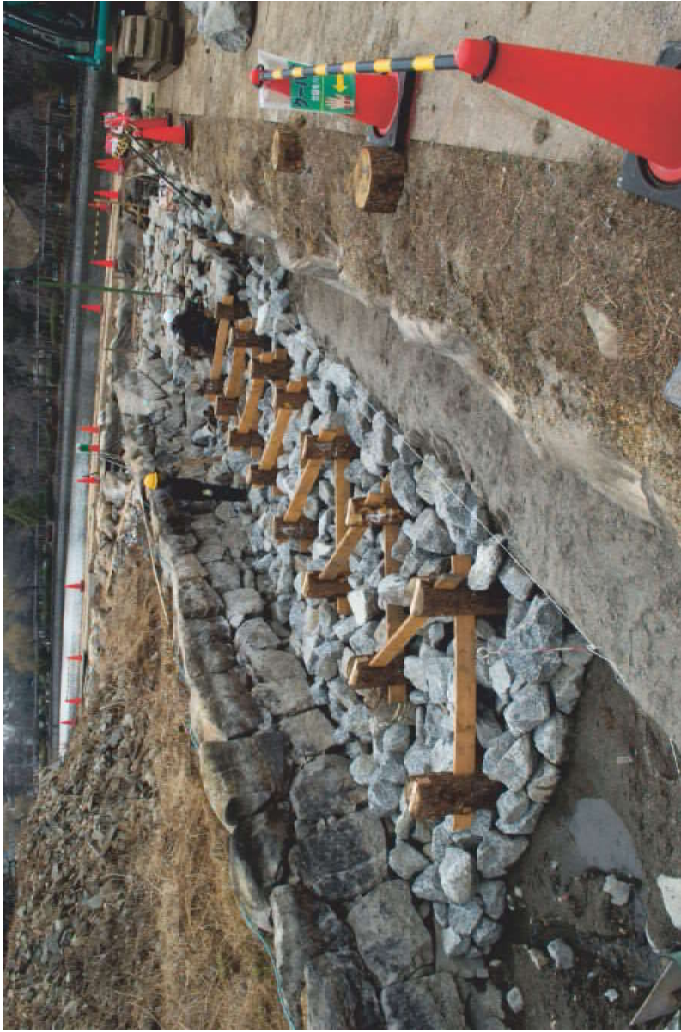
2 本丸搦手馬出石垣東面 貫設置・下層捨石敷設状況 南東から
