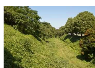
土塁・堀に繁茂した草本類 (東門跡北)
