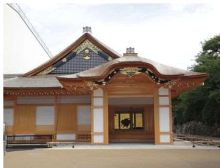
写真 本丸御殿（玄関・車寄外観） （現在）
