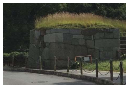
狭小な歩道（二之丸東門枳形付近）
