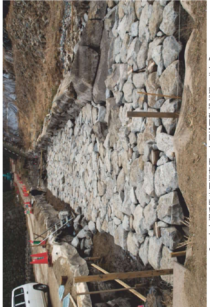
1 本丸搦手馬出石垣東面 杭打設状況 南東から
