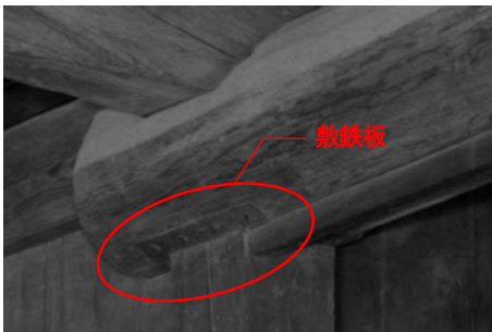
敷鉄板が写っている写真（竹中工務店画像加工） ガラス乾板写真(天守閣一階内橋台上下側の石落及び鉄砲狭間) (名古屋城総合事務所所蔵)
