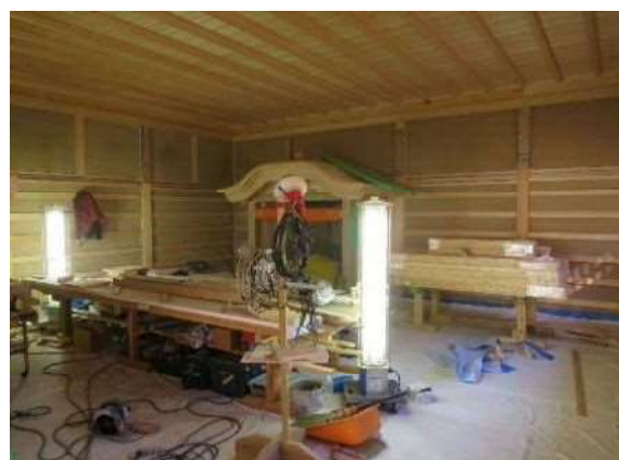
◎ [湯殿書院] 内部状況
