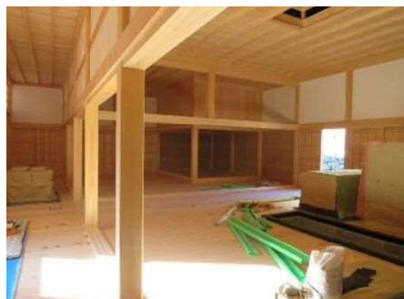
◎ [上御膳所] 内部状況
