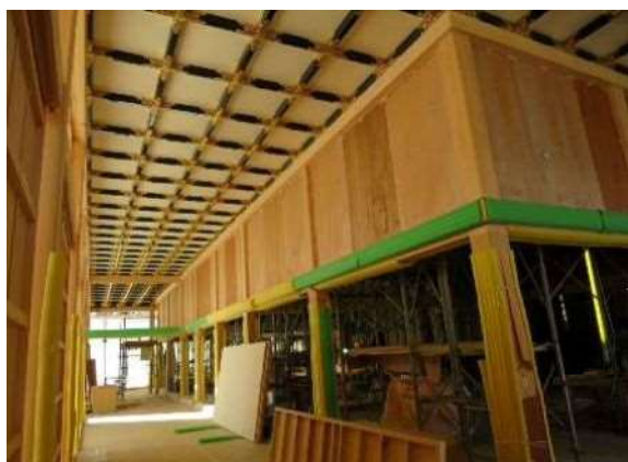
◎ [上洛殿] 内部状況
