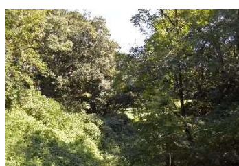
土塁・堀に繁茂した樹木・草本類 (本町橋東)
