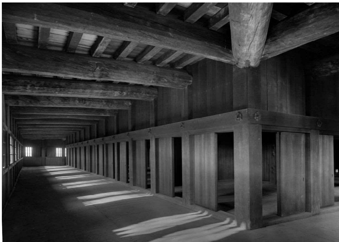
ガラス乾板写真 天守閣1階内西入側（焼失） 昭和初期 名古屋城総合事務所所蔵
