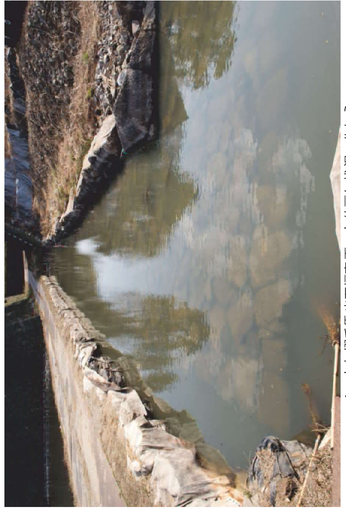
2 本丸搦手馬出石垣東面 貫設置・下層捨石敷設状況 南東から
