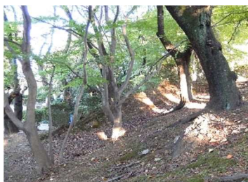
土塁法面に傾斜して植わってい る樹木（大手馬出南側土塁）
