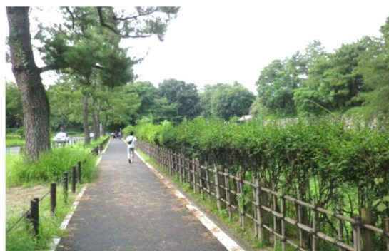
灌木の背丈が高く石垣が見えない （二之丸西空堀付近）
