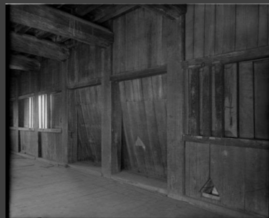
ガラス乾板写真 (左)天守閣一階内西入側 (右)天守閣一階内橋台上南側の石落及び鉄砲狭間(名古屋城総合事務所蔵)
