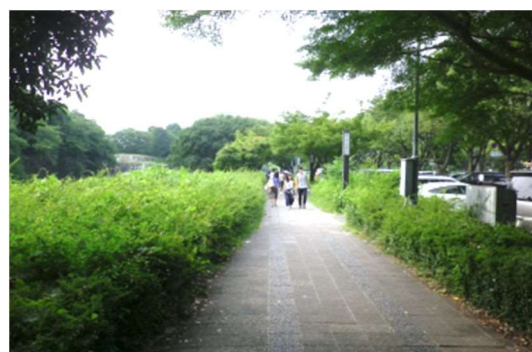
灌木が繁茂し石垣・堀が見えない （二之丸南東空堀付近）
