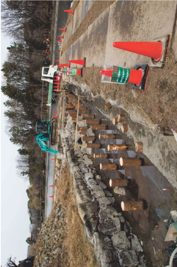
1 本丸搦手馬出石垣東面 杭打設状況 南東から
