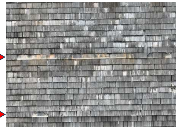
写真 2 玄関屋根（西面）
