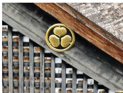
写真 42 漆色褪せ、胡粉の剥離
