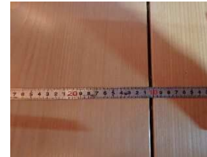
写真 7 床板の隙間
