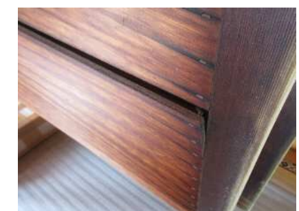
写真 15 建具 板の反り
