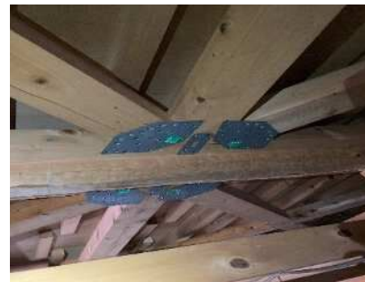
写真 26 小屋裏 構造補強
