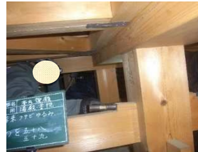
写真 34 床貫 楔締め直し
