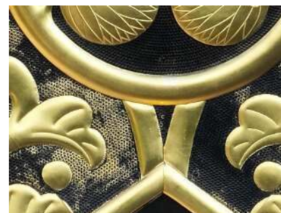
写真 44 墨差しの剥がれ
