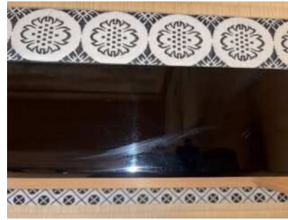
写真 19 トコ框 漆の傷
