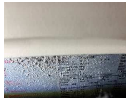
写真 27 空調機器の汚れ
