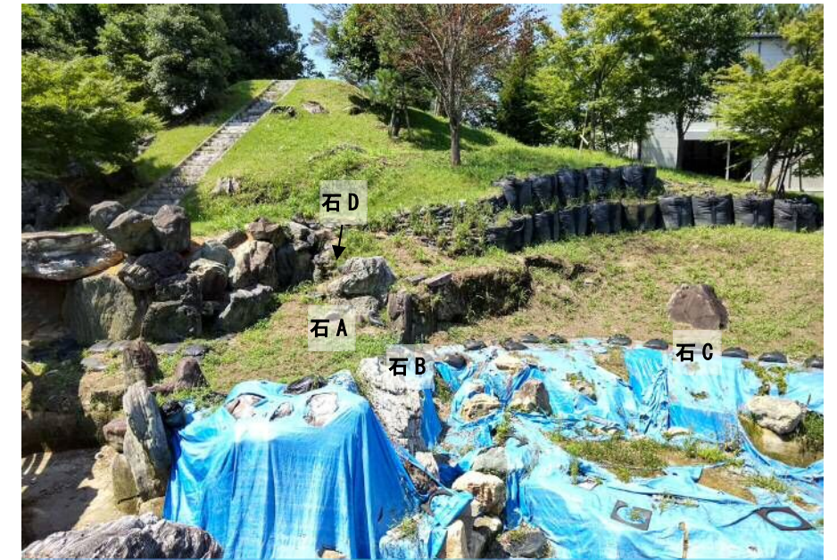
写真1 現況写真（南から撮影）
