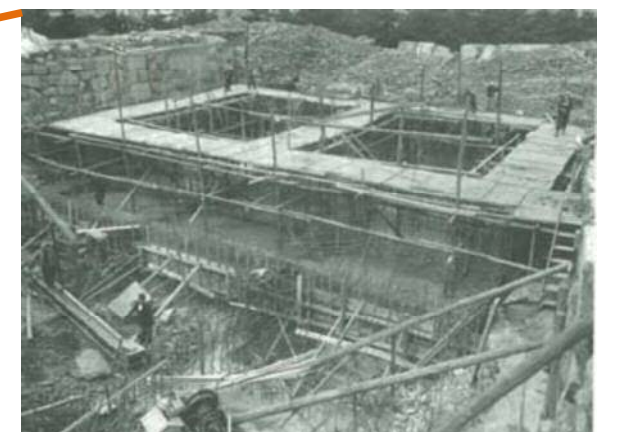
『名古屋城再建』p.44 昭和33年2月1日の記事 「地中梁の排菌が進みコンクリートを打っている」 北側の石垣が大きく崩されている。
