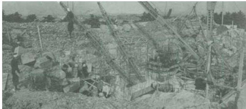
『名古屋城再建』p.45 昭和33年2月11日の記事 北側と東側明り取り窓までの石垣が大きく崩されている。
