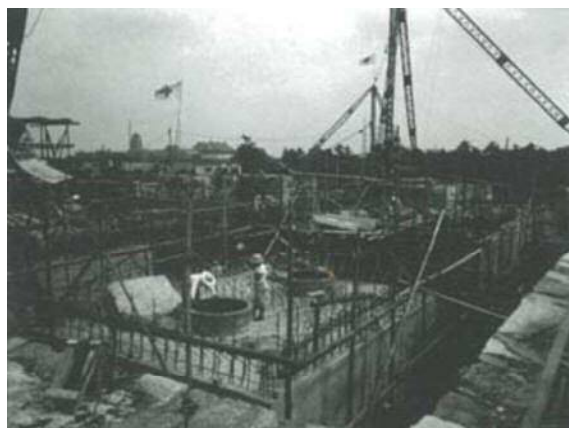
『名古屋城再建』p.27 昭和32年8月11日の記事 「沈下準備の終わった大天守のケーソン」 周囲の穴蔵内側の石垣はまだ崩されていない
