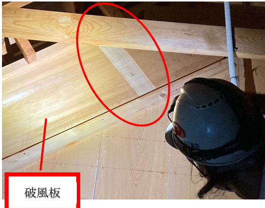
写真4（落下した吸付棧の元位置）
