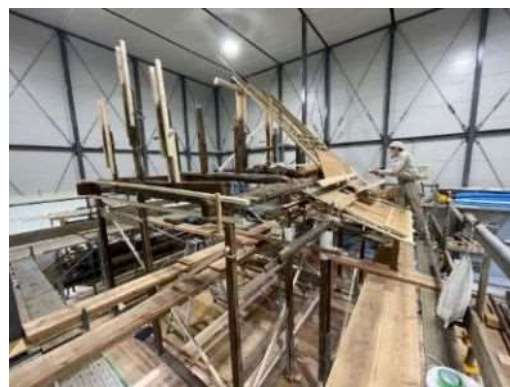
R3年仮組調査状況
