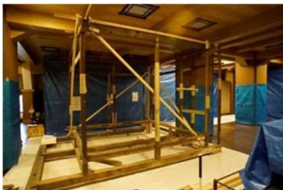
H30年仮組調査状況
