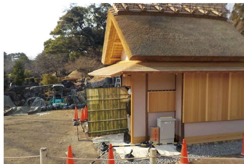
写真2-13 袖垣（南側）実寸模型設置状況 （東側より）
