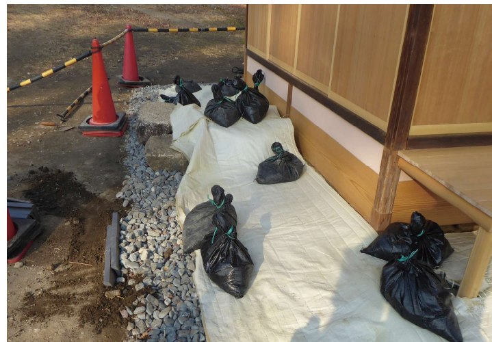
写真 5-1 熨斗瓦設置状況
