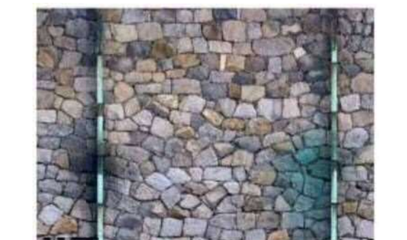
図07 U061_築石部中段_布積崩し.jpg
