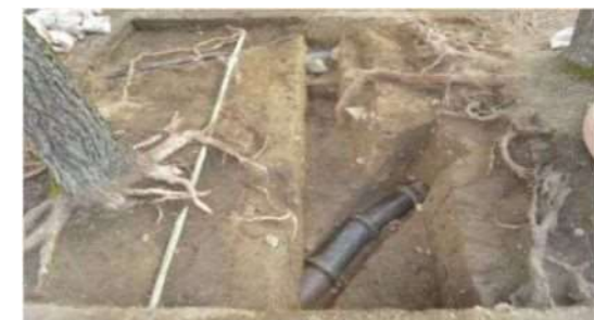
写真3 A区 完掘状況
