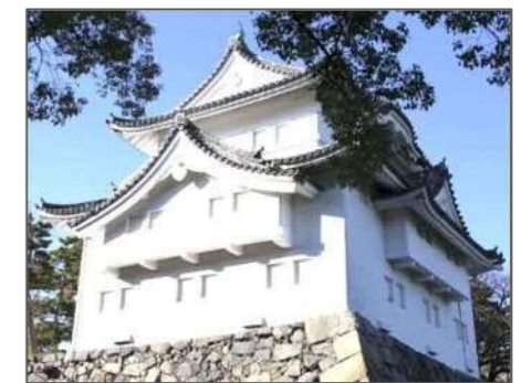
東南隅櫓（重要文化財）
