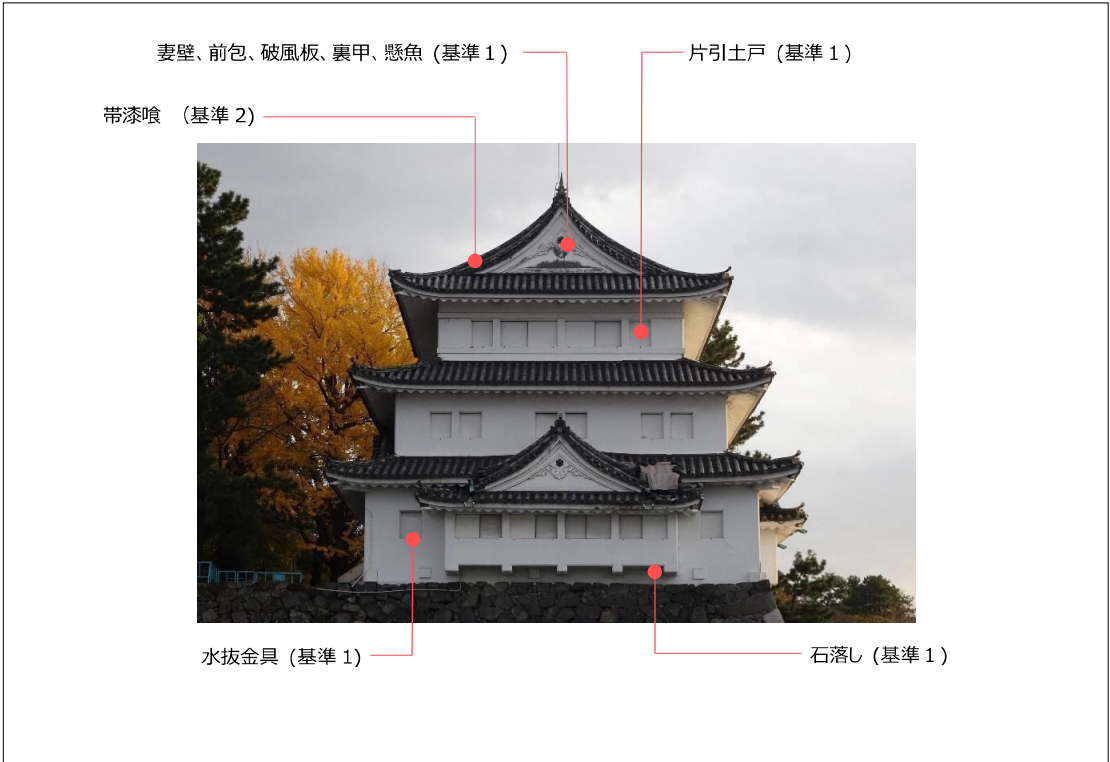
西北隅櫓外部
