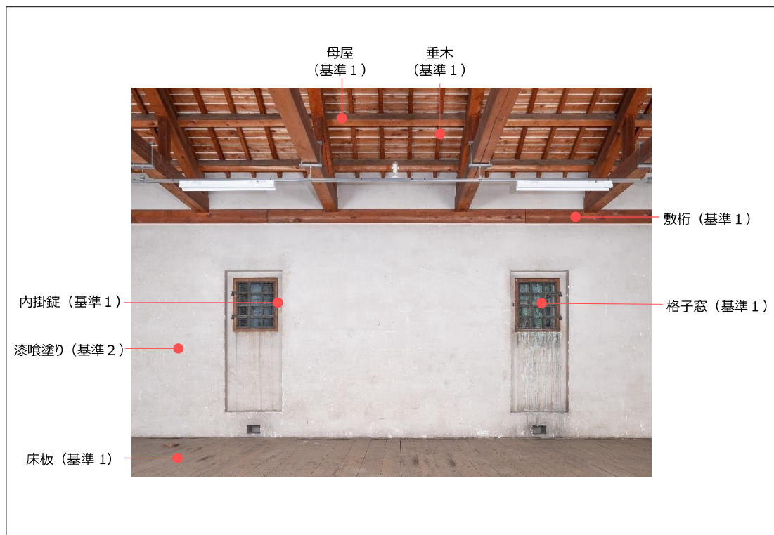
乃木倉庫内部北面
