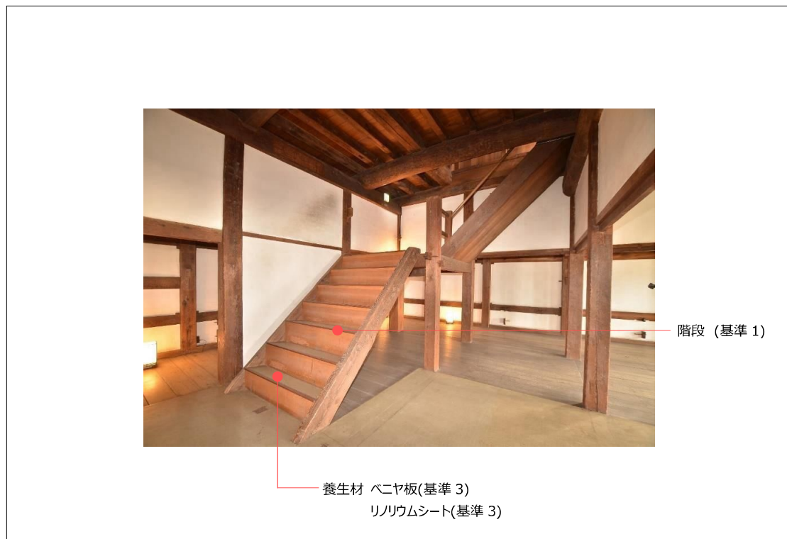
西北隅檣内部 2 階
