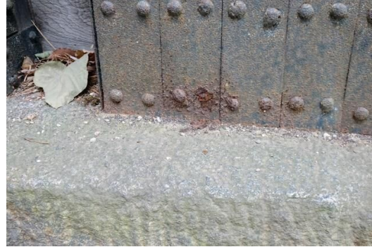
写真 14 【旧二之丸東二之門 (A04)】 鋳の欠損
