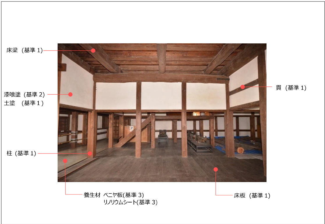
西北隅櫓内部 1 階
