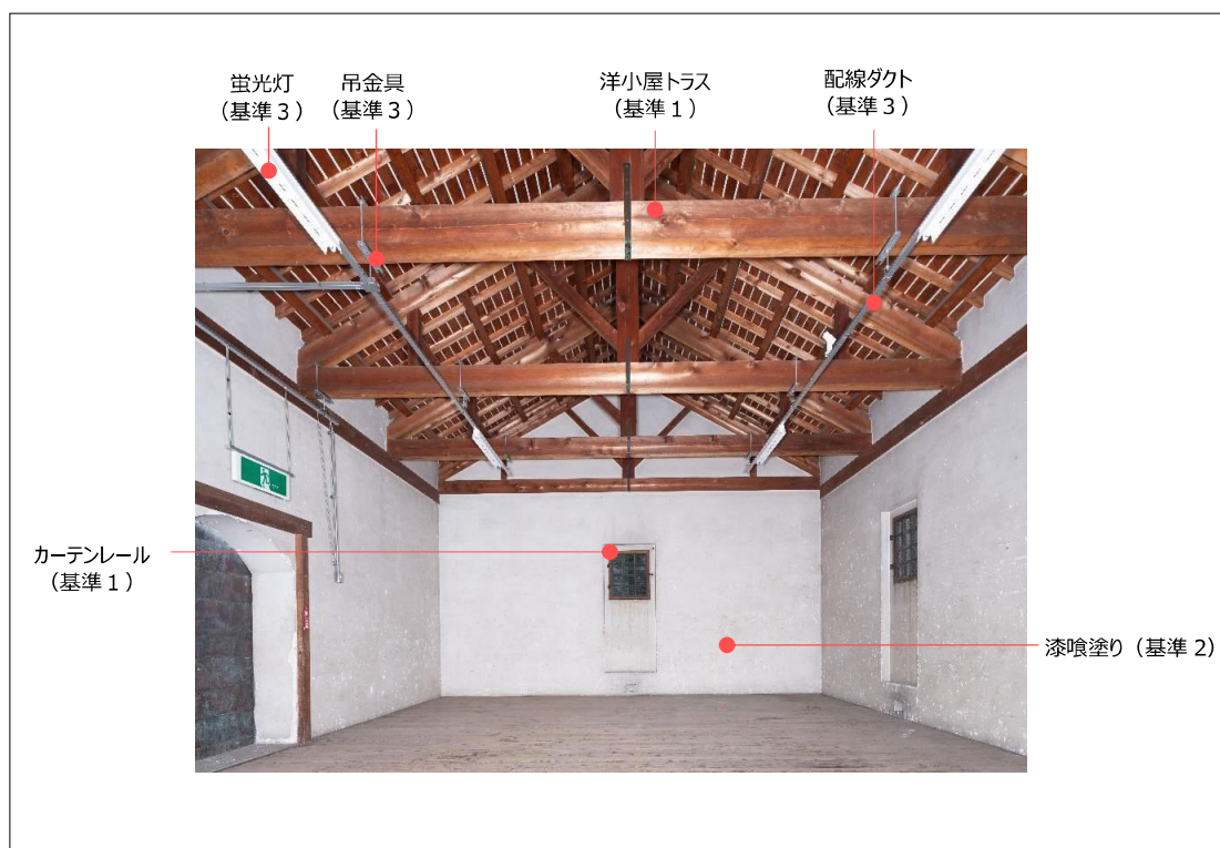
乃木倉庫内部西面
