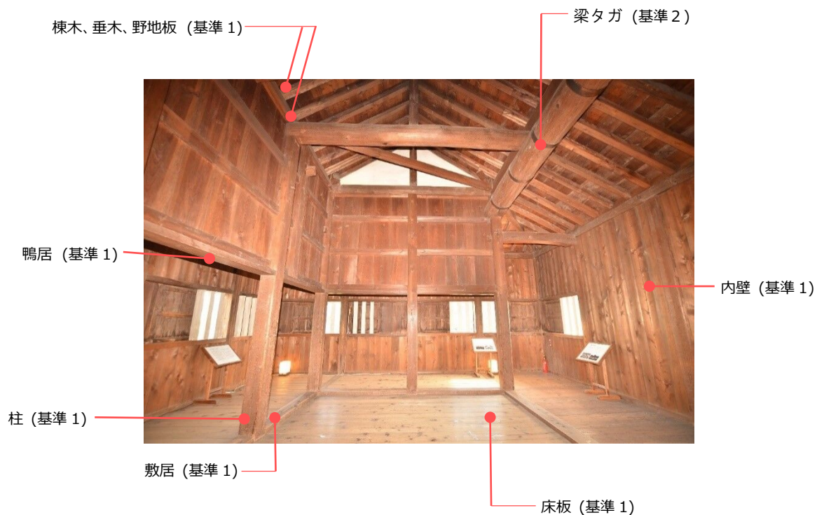
東南隅櫓内部 3 階
