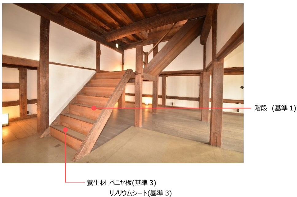
西北隅櫓内部 2 階
