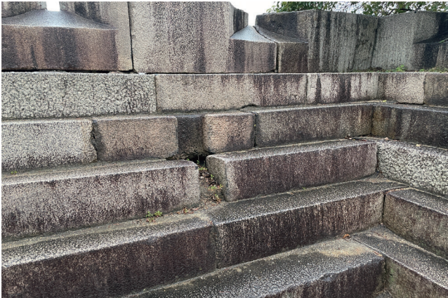
図6 大坂城玉造門（控柱に合わせて2段分掘り込む）
