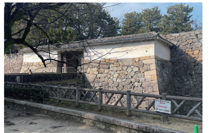
図4 表二の門現況写真（南東から）
