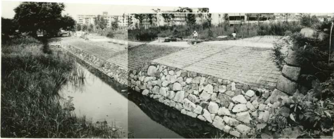
写真 2 工事完成直前の全景写真：北東向き（昭和 49 年（1974）6 月）
