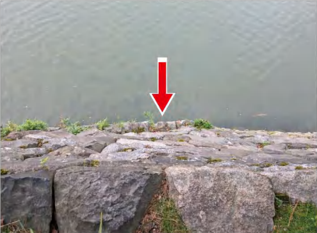
1970-72 年積み直しのセットバック状況
