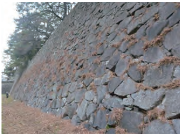
図 4-33 253W 石垣面の膨らみ
