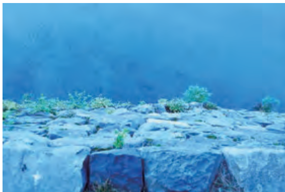
図 4-40 224〇 石垣面の段差(上から)
