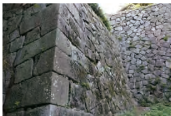
図 4-32 254W 石垣面の膨らみ
