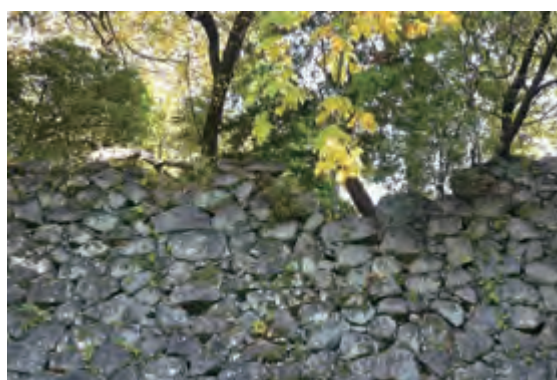
図 4-28 161N 天端、築石部の一部欠落
