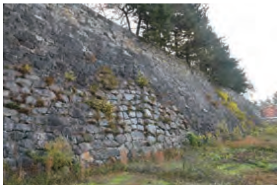
図 4-23 005H(U56) 石垣面の膨らみ
