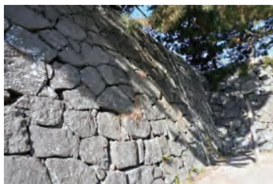
図 4-12 038H 石垣面の膨らみ
