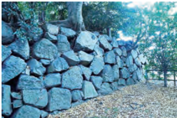
図 4-43 248〇 樹木根による変形
