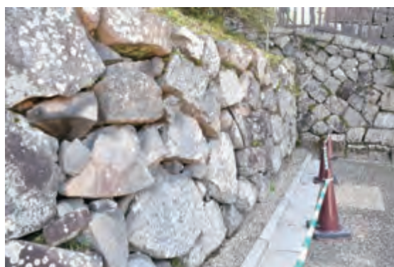
図 4-14 094H 石垣面の膨らみ
