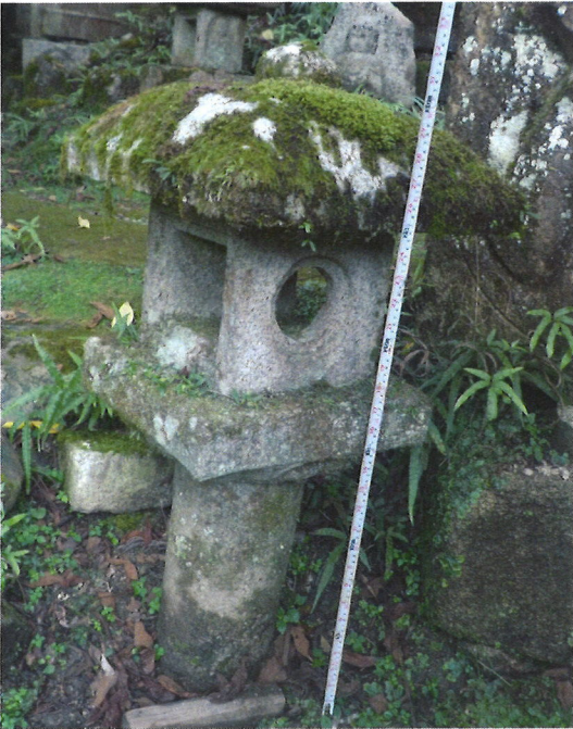
写真 2-15 四角型燈籠 古材事例 (H=3 尺 2 寸)
