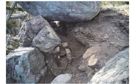
手水石及び石組みAを田又で固定し、隙間の樹木根を全て取り外す。樹木根を除去後に石組みAが下落する恐れがあるため、詰石を入れ、混合土を充填する。
