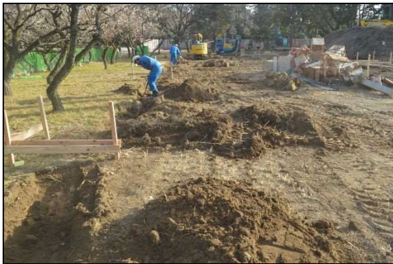
写真2 現場状況／北から
