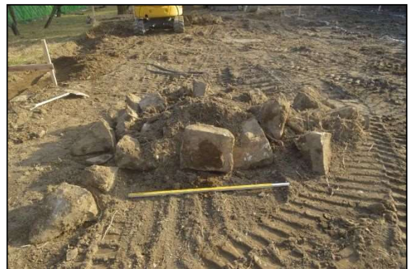
写真3 き損した石材状況／北から
