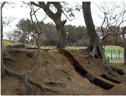
図5 風信全景(南西から)
