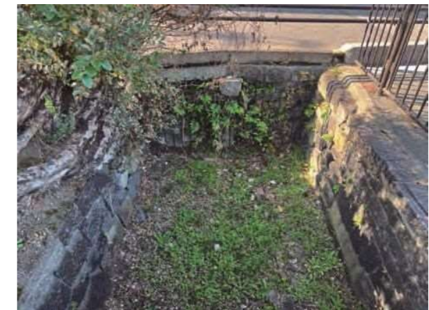
図4 辰之口水道の排水部分(東から)
