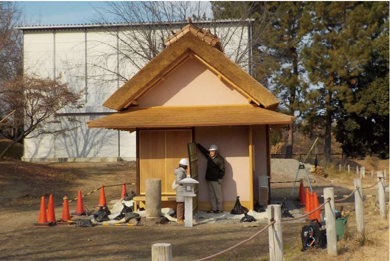
写真2-2 袖垣（南側）実寸模型設置状況 （南側より）
