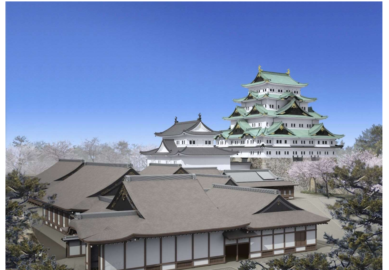
図-1.2.2 ・更なる経年変化で2重から4重も緑青色となった状態 妻壁は垂直面のため、酸化の進行が極めて遅く、 黒油塗、酸化銅により黒色、黒褐色の状態 ⇒焼失前の姿
