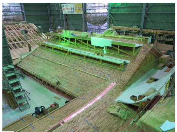
④ [黒木書院] 屋根状況 (南東より臨む) [H29. 8]
