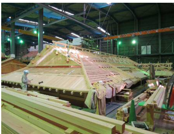
⑤[湯殿書院] 屋根状況 (北西より臨む) [H29. 8]
